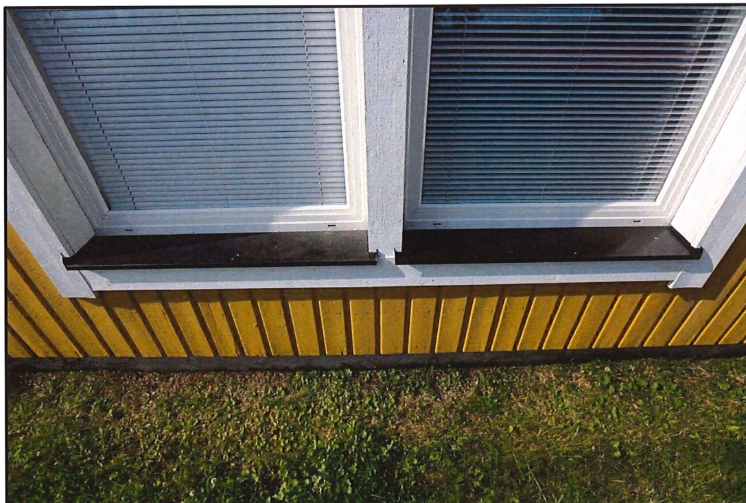
Figur 25 visar utsidan av fönster i vardagsrum/sovrums.
