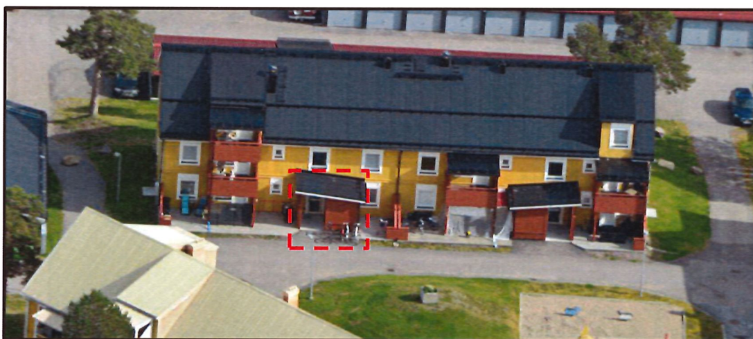
Figur 4 Närbild Glaciärvägen 6A, Kiruna västra långsidan. Ingången till glaciärvägen 6A är markerad.
