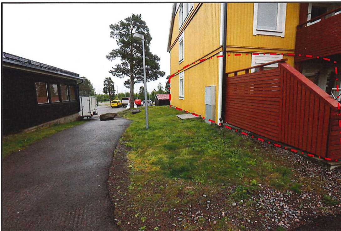
Figur 3 Norra gavel Glaciärvägen 6, Kiruna. Sandbergs lägenhet är markerat i figur 3. Parallellt med den norra gaveln finns en asfalterad gångväg. Vägen är blockerad med en större sten i anslutning till parkeringsplatsen. Passagen på gångvägen bedöms inte möjlig att passera med personbil.
