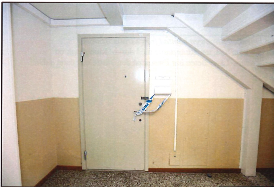
Figur 7 Entrédörren till Larssons lägenhet. Lägenhetsdörren är en vänsterhängd slagdörr i metall. Dörren har ett titthål och låset är ett ASSA hakregellås. Låsvred på insidan. Dörren är märkt på högra sida av det övre dörrfodret med siffrorna "1002" och "0092". Ovanför nyckelhålet fanns en ledhasp låst med hänglås.
