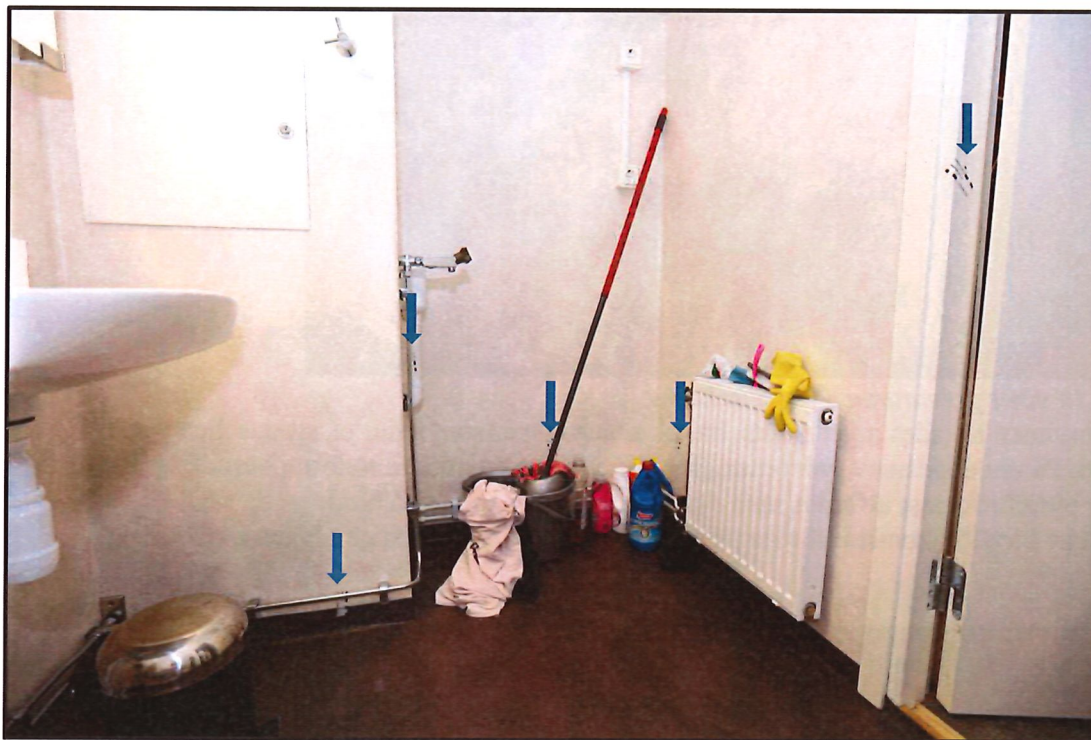
Figur 15 badrummets västra vägg.
