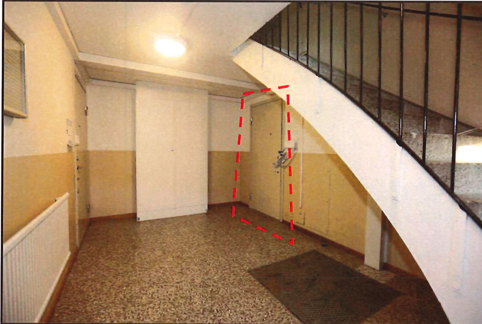
Figur 6 Entréhall Glaciärvägen 6A, Kiruna med Larssons lägenhet markerad. Markerad i figur 6 har entrédörren till den undersökta lägenheten. På insidan av entrédörren till fastigheten och utsidan av lägenhetsdörren hittades mindre rödbruna besudlingar. Ett test av blodförekomst utfördes men gav ingen indikation på blod. UV-ljuskälla användes för att söka efter fluorescerande spår. Vid undersökningen i trapphuset påträffades inga spår som bedömdes vara intressanta för utredningen.
