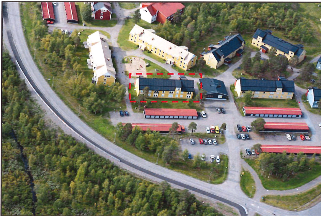
Figur 1 Översiktsbild Glaciärvägen 6A, Kiruna. Östra sidan. Adressen markerad i figur 1.
