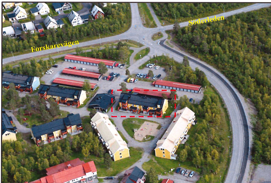
Figur 2 Översiktsbild Glaciärvägen 6A, Kiruna. Västra sidan. Adressen markerad i figur 2.
