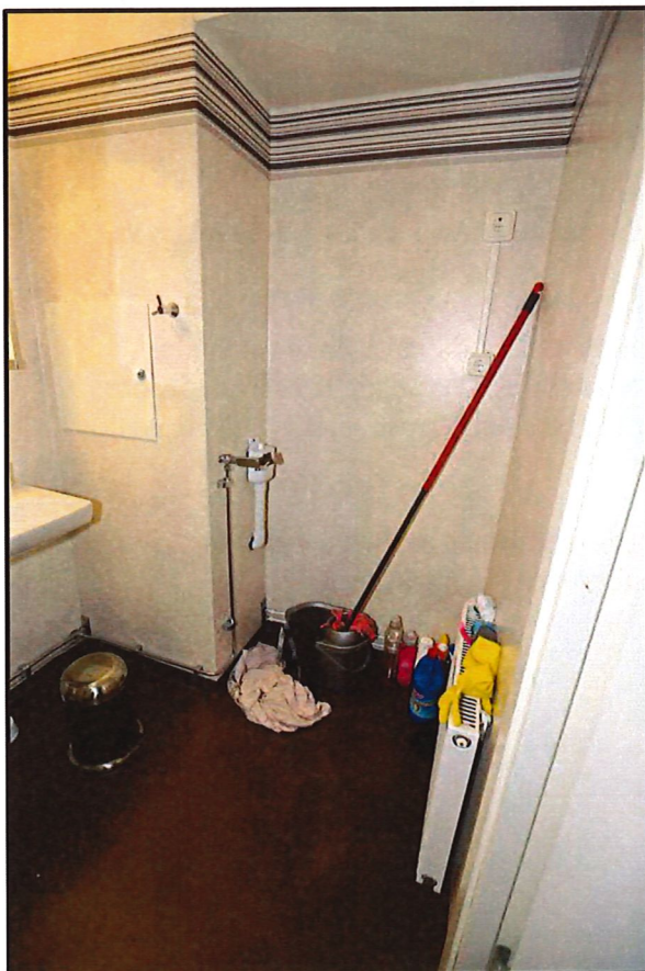
Figur 14 visar badrummets vägg mot kök, västra väggen.
