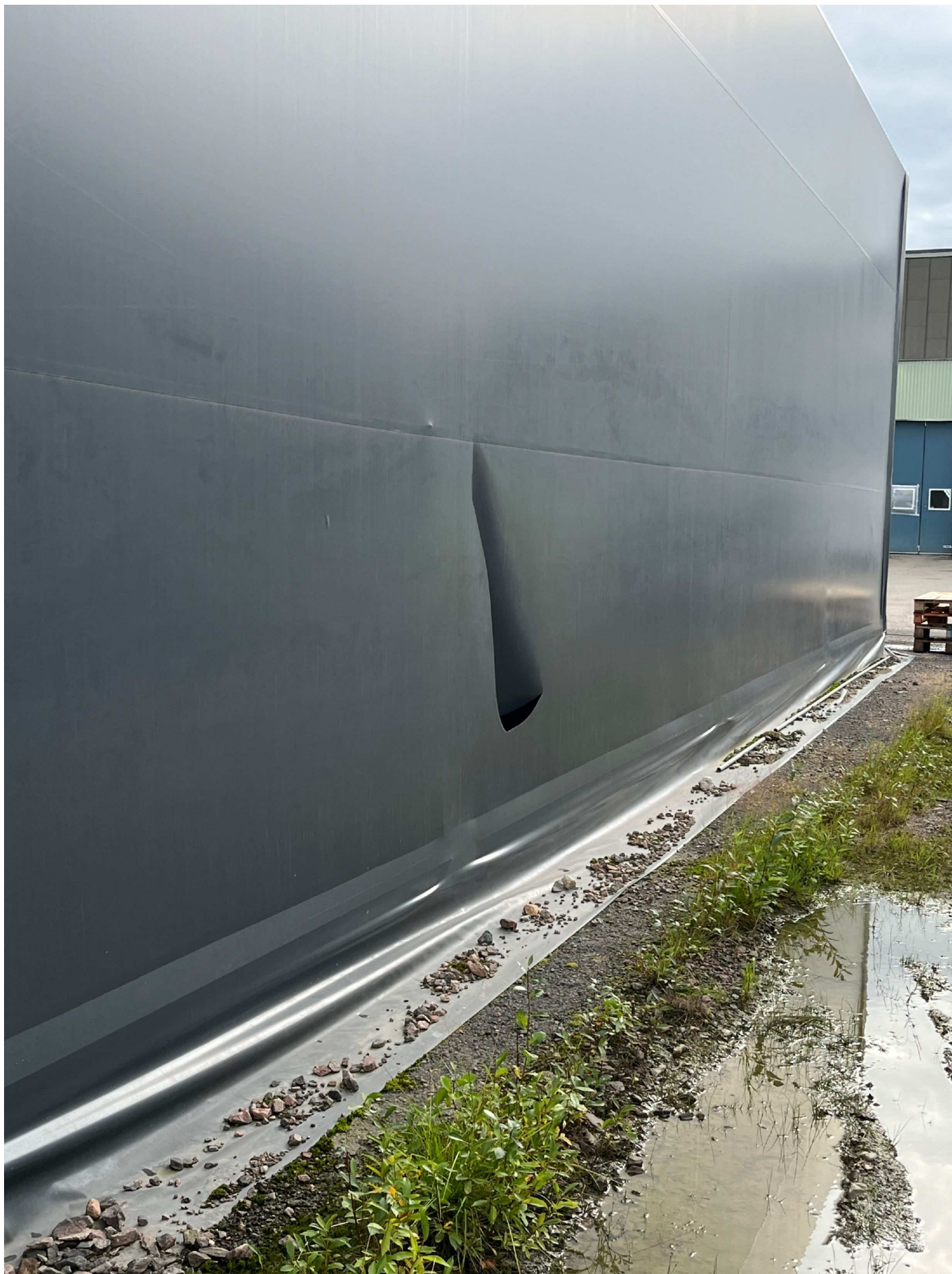
7. Fotografi taget av pa A Stuge 240820 kl 12.51 på Oljevägen 11 Hydralservice, Gällivare. Bilden visar uppskuren ingångsöppning vänster sida av tält 1, bilden taget utifrån.
