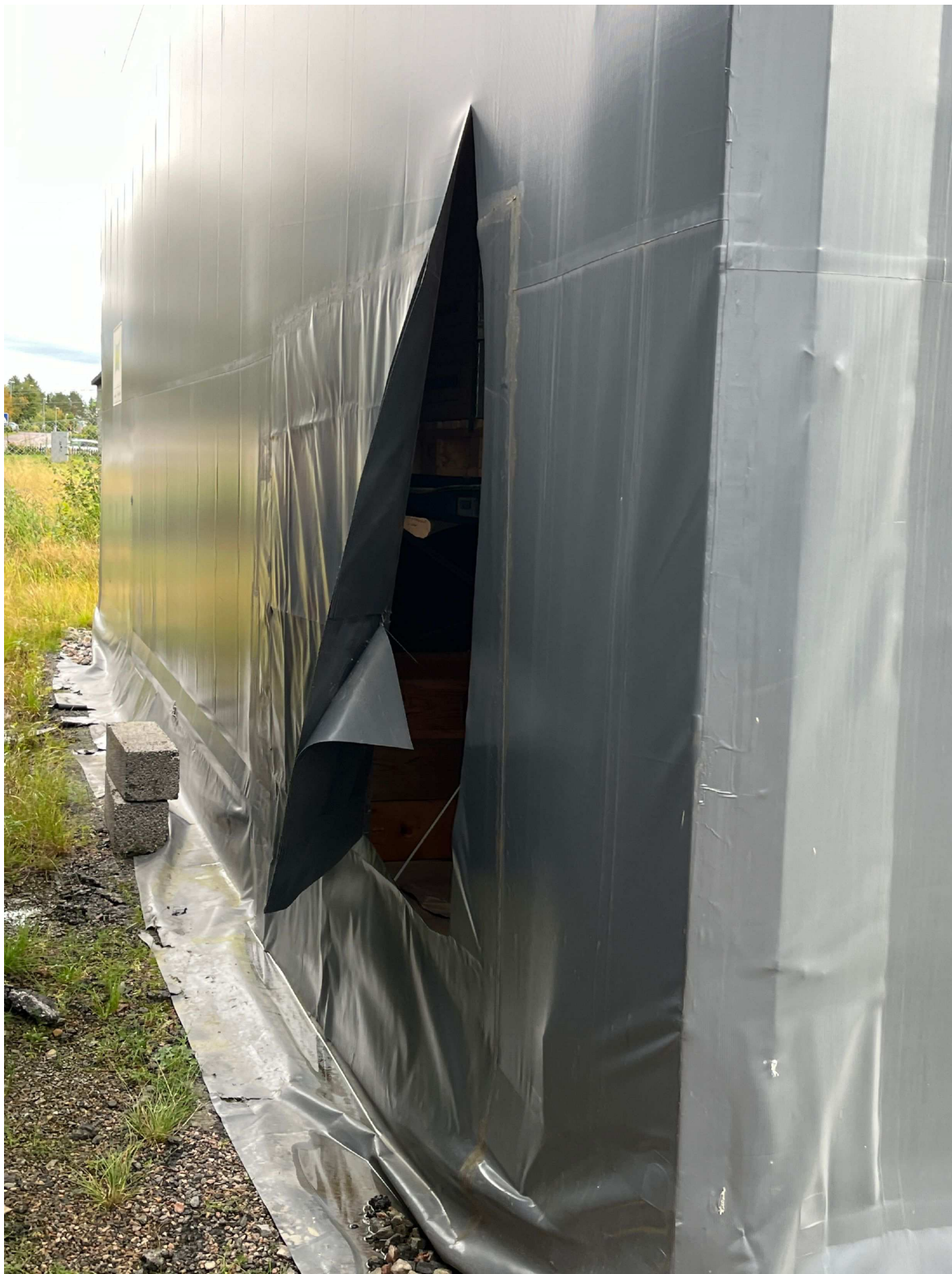
5. Fotografi taget av pa A Stuge 240820 kl 12.51 på Oljevägen 11 Hydralservice, Gällivare. Bilden visar uppskuren ingångsöppning baksidan av tält 1, bilden taget utifrån.
