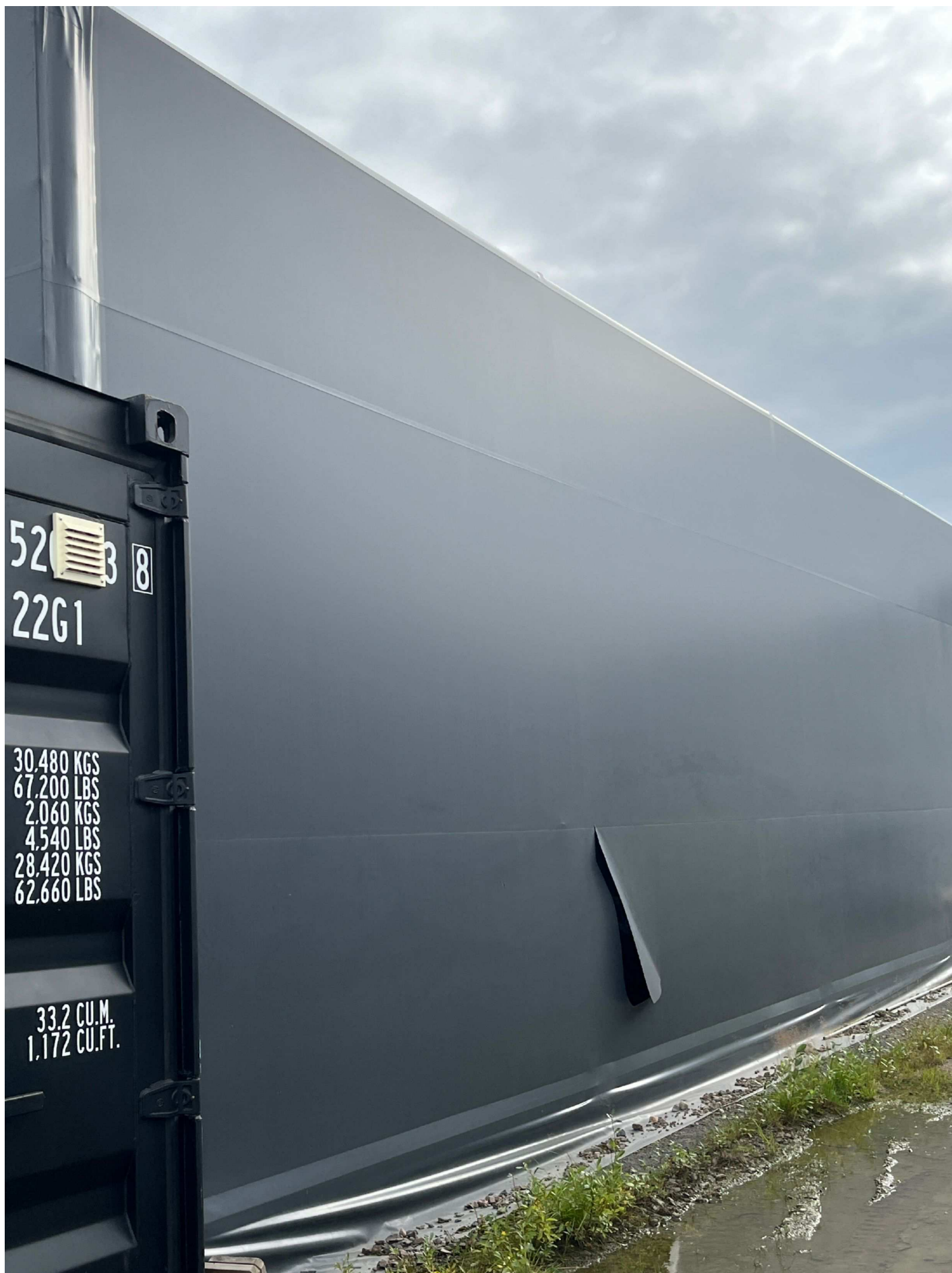
8. Fotografi taget av pa A Stuge 240820 kl 12.51 på Oljevägen 11 Hydralservice, Gällivare. Bilden visar uppskuren ingångsöppning vänster sida av tält 1, bilden taget utifrån.
