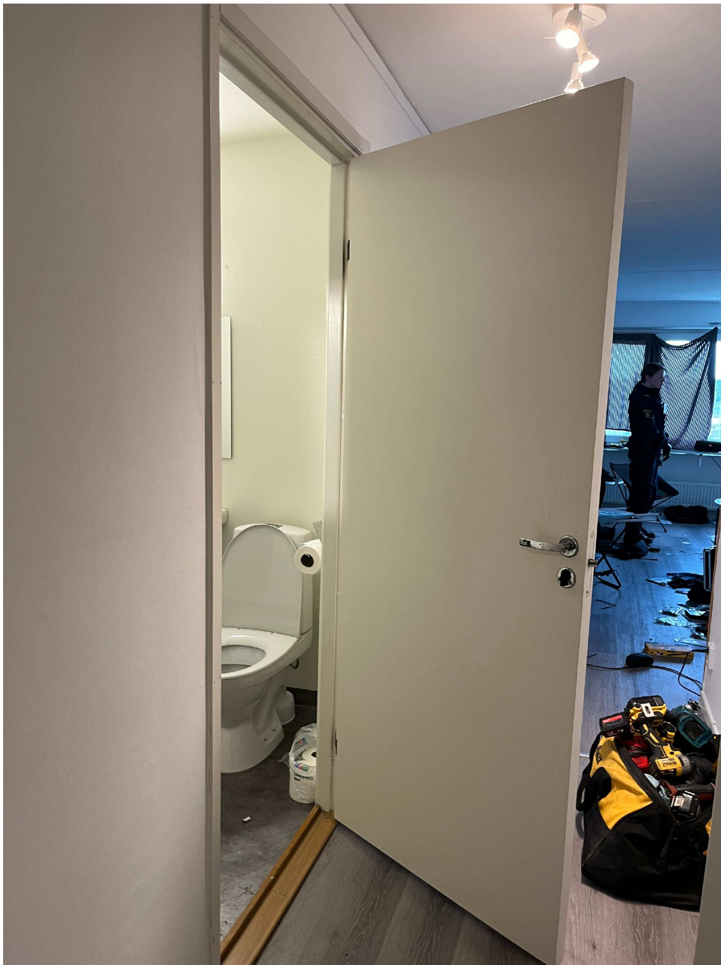
2. Fotad av Pa C.Eliasson den 2024-08-21 ca klockan 16:43. Bilden visar dörren in till badrummet.
