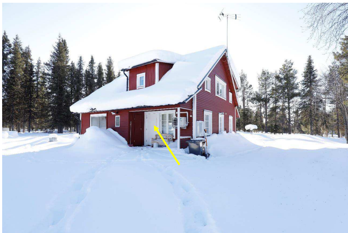
Figur 4. Översiktspild utvändigt av det undersökta huset. Entrédörr markerad med pil.
