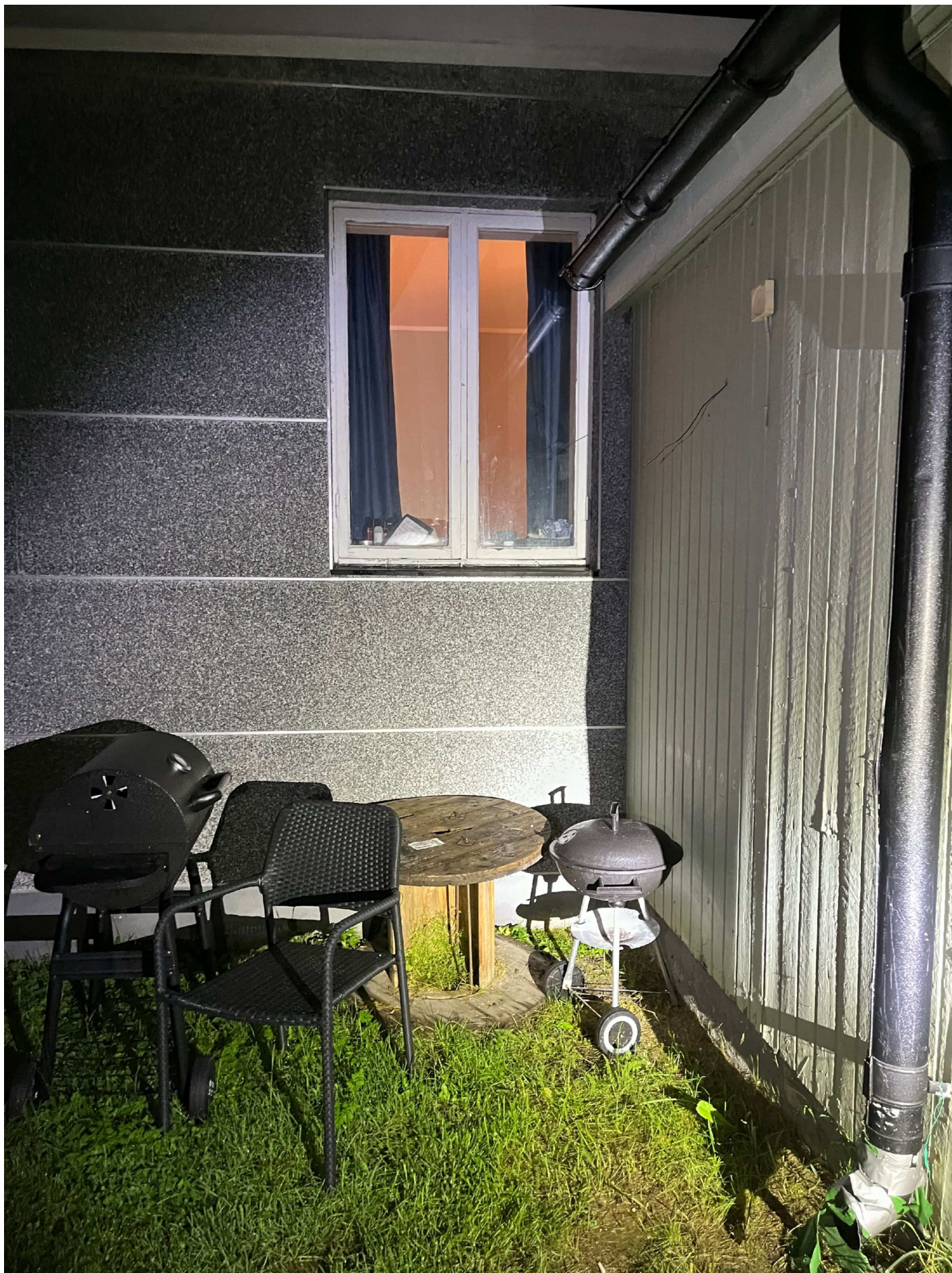
1. Fotad av Pa C.Eliasson den 2024-08-22 klockan 23:56. Bilden visar fönstret där den misstänkte ska klättrat in genom.
