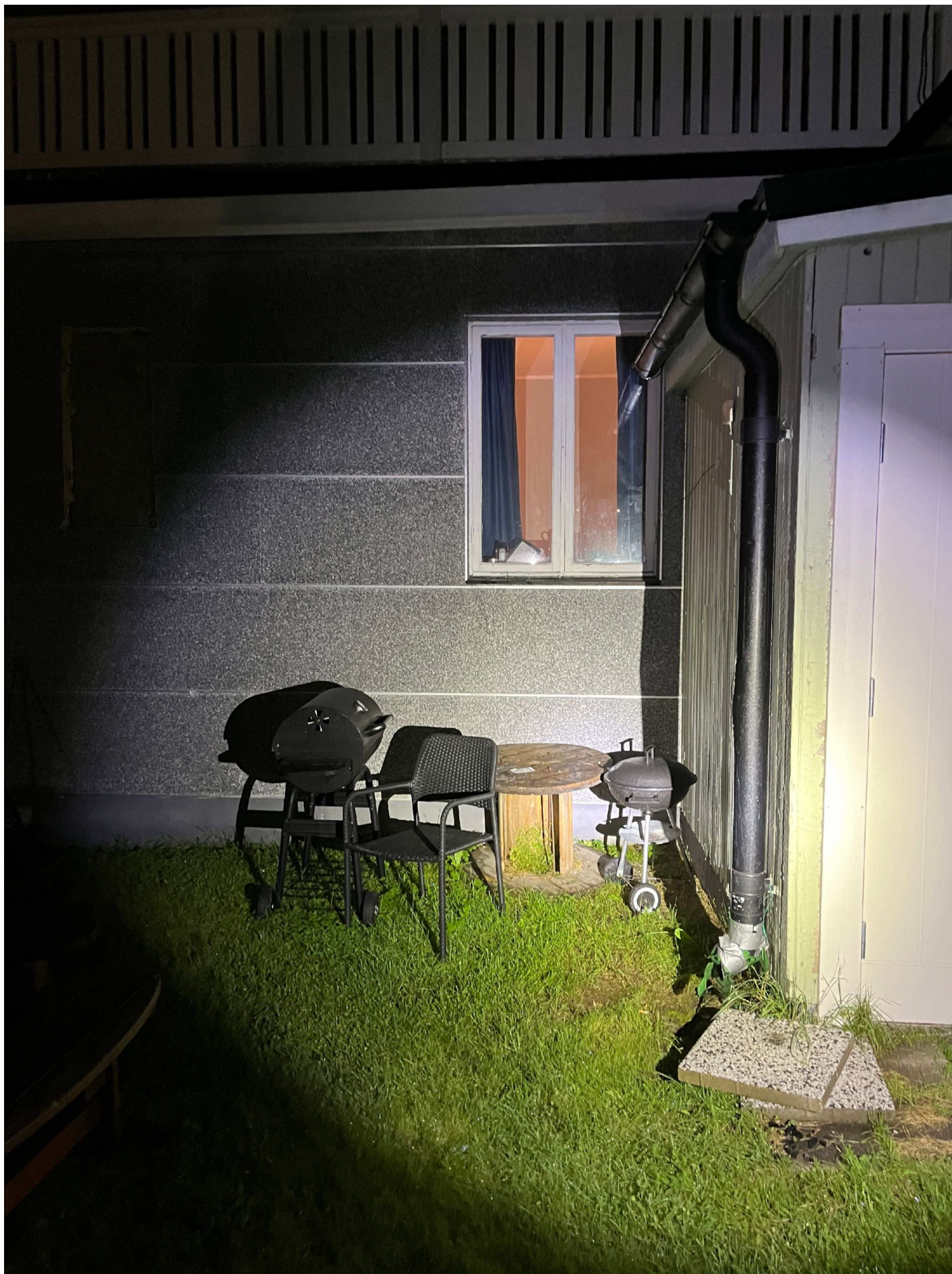
2. Fotad av Pa C.Eliasson den 2024-08-22 klockan 23:56. Bilden visar fönstret där den misstänkte ska klättrat in genom.
