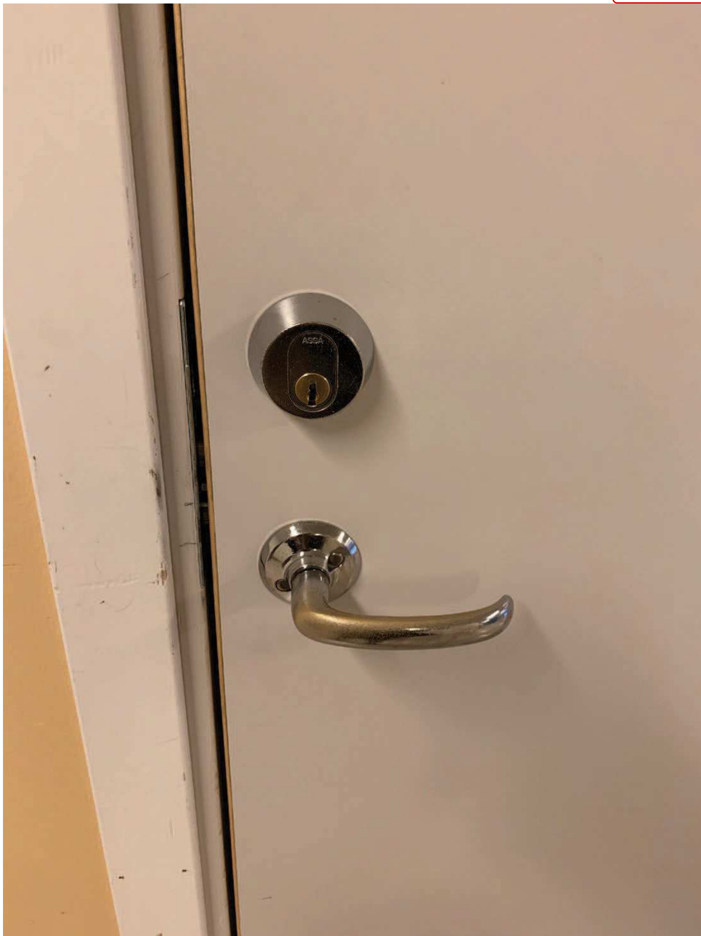
8. Bild visandes handtag och lås på behandlingsrum (nr 13) på avdelning 27, psykiatrin, Gävle sjukhus. Bild tagen 20220104 av utredare A. Wikner.
