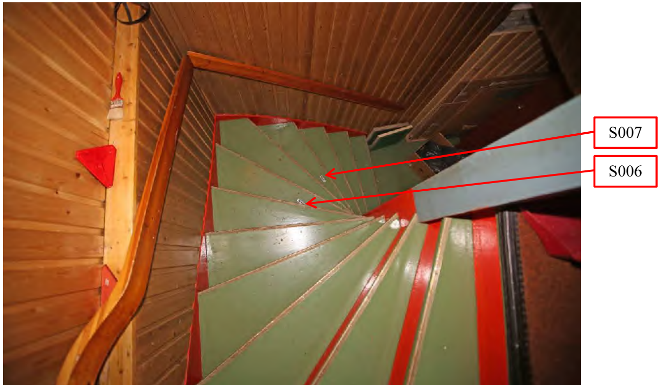
Figur 13 Bild på källartrappan fotograferad uppifrån.
