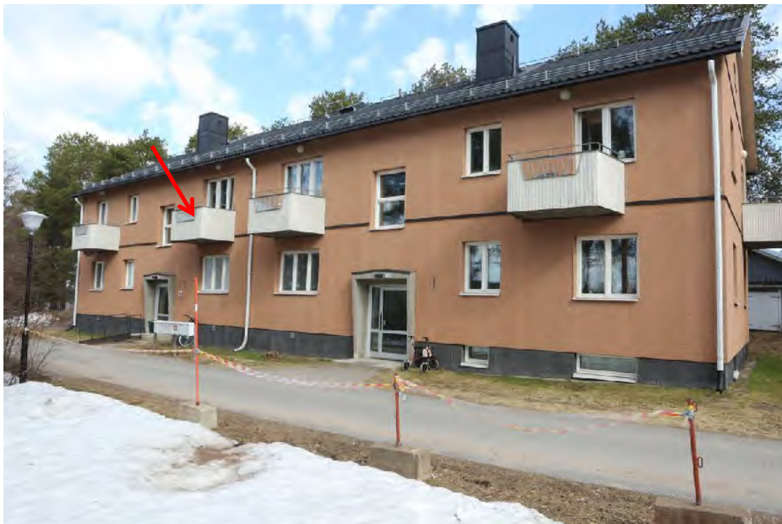
Figur 2 Översiktsbild av den södra långsidan. Pilen markerar balkong till den undersökta lägenheten.
