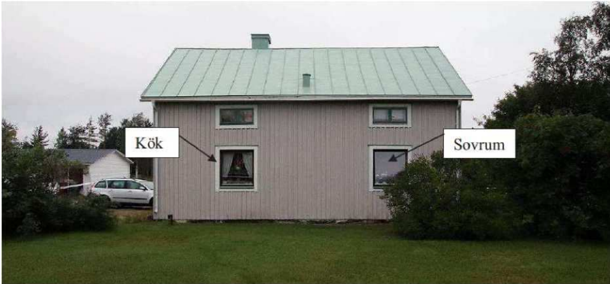
الصورة 4 تبيّن الصورة العامة الجهة الخلفية من المسكن في دانييلسفيغين 2. تتوجه الصورة من طريق بيوركفورسفيغين.
