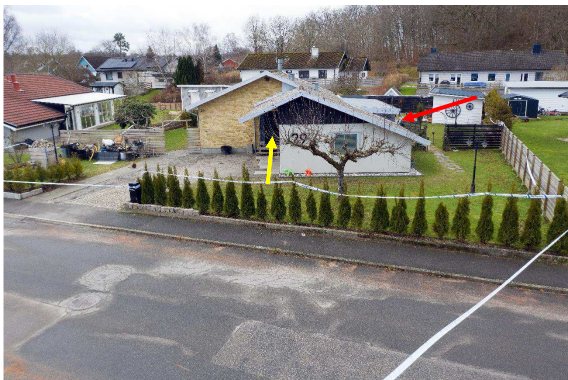
Figur 6. Drönbild tagen i samband med platsundersökningen 2023-02-01. Granliden 29. Gul markering visar entrédörren. Fotot är taget vid området för uppfart/infart Granliden 28. Röd markering visar inglasat uterum och dess ingång.
