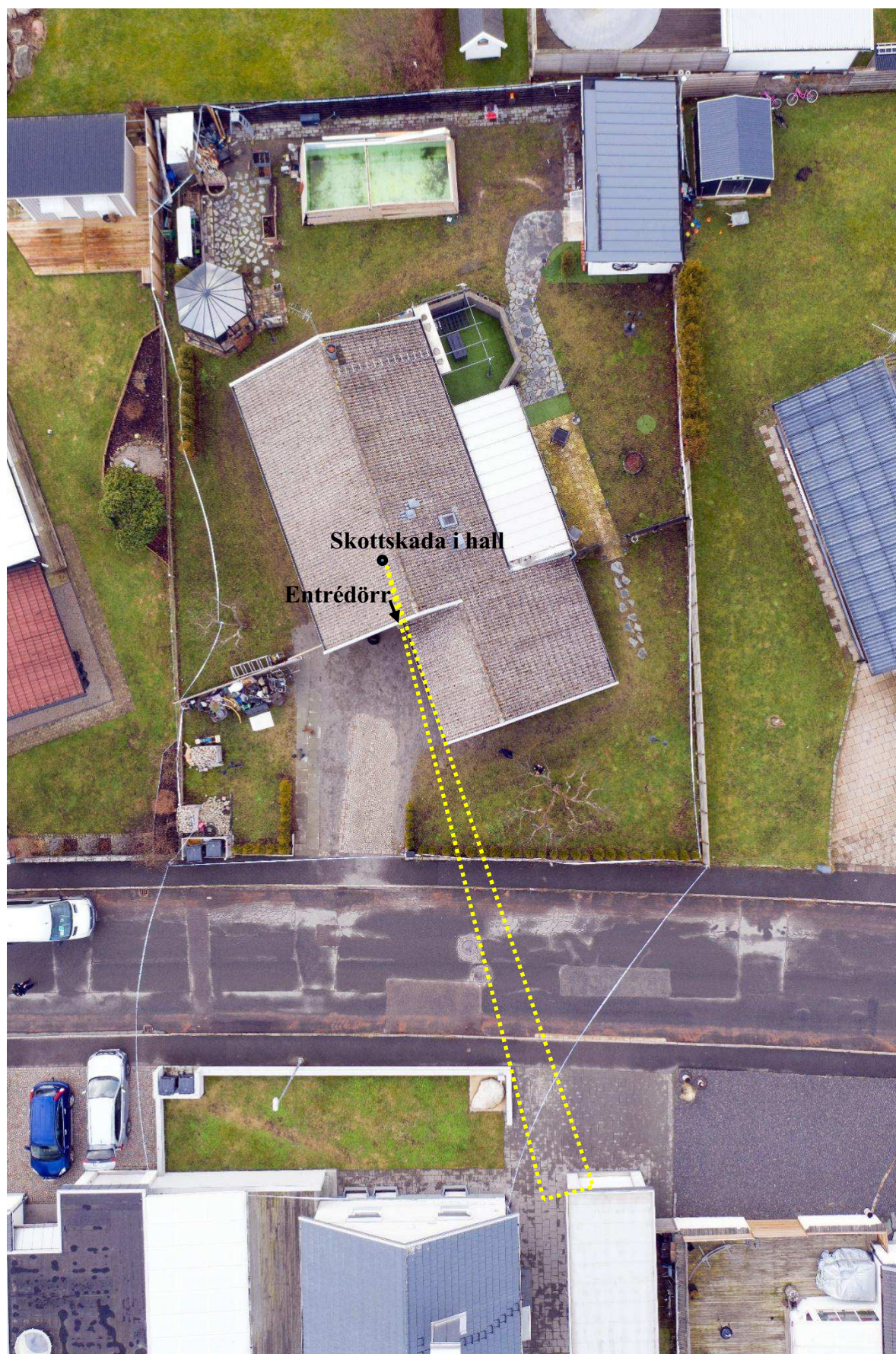
Figur 21. Drönbild 2023-02-01. Schematisk markering av området för laserstrålens riktning från skottskadan i hallen mot garaget Granliden 28.
