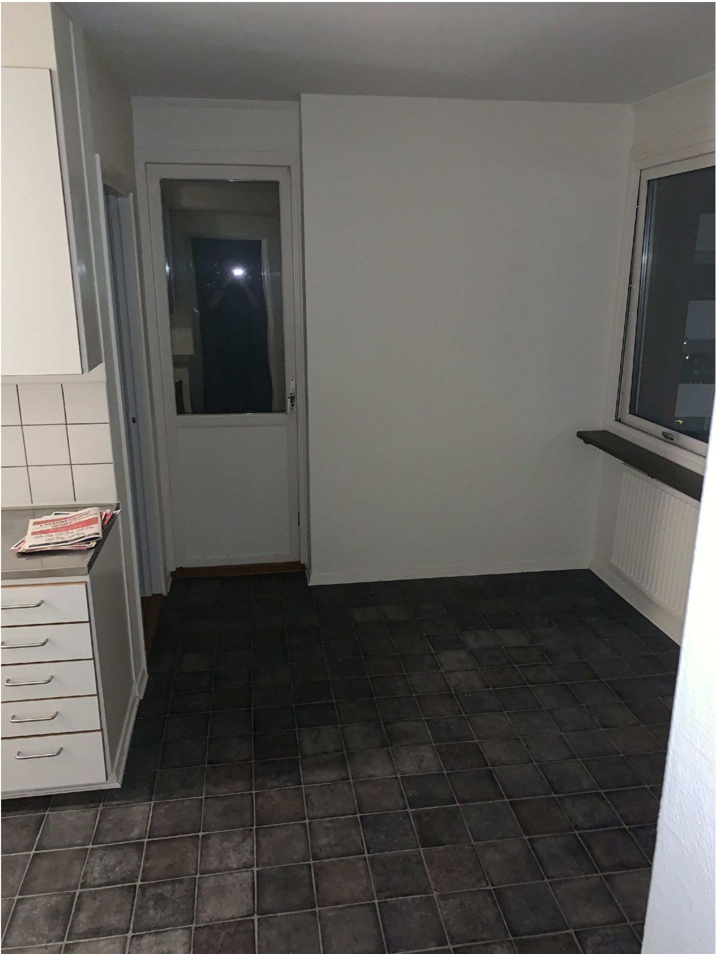
3. Göttagatan 1F, bild ut mot balkong taget från köket.
