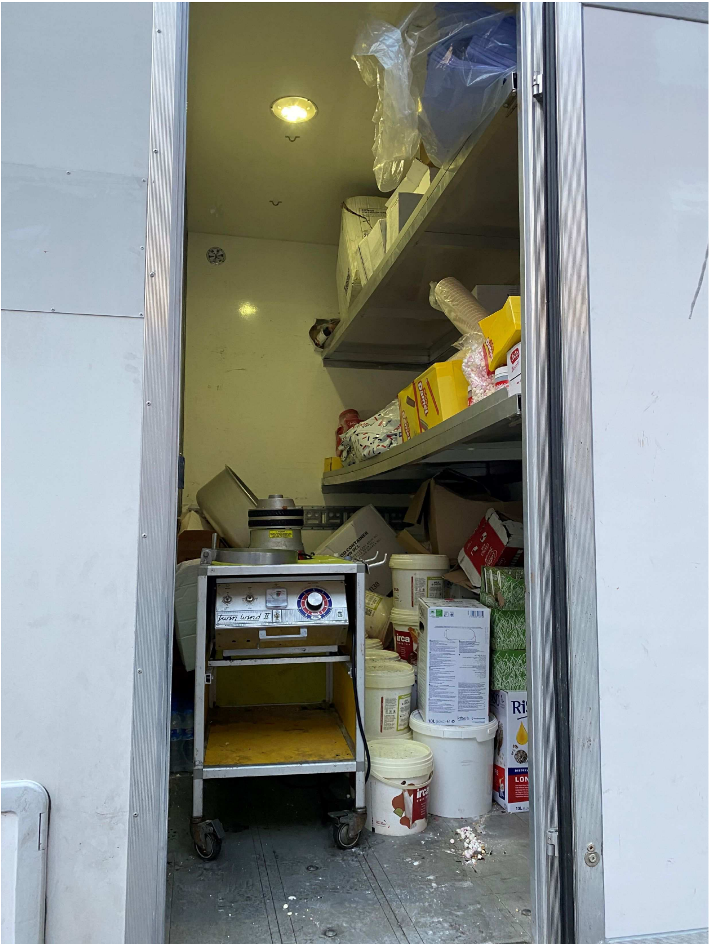
7. Översiktsbild in i lastutrymme (lagerutrymme 1). Inget anträffades där
