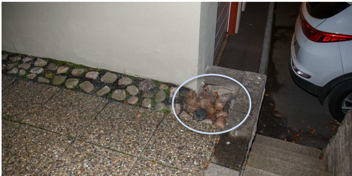
Bild 17. Bilden visar byggnadens nordvästra hörn
