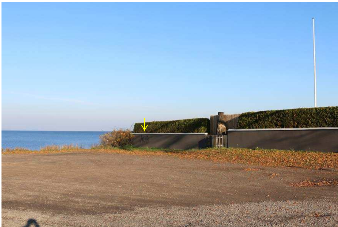
Bild 4. Muren sedd från sydväst. Pilen markerar texten.
