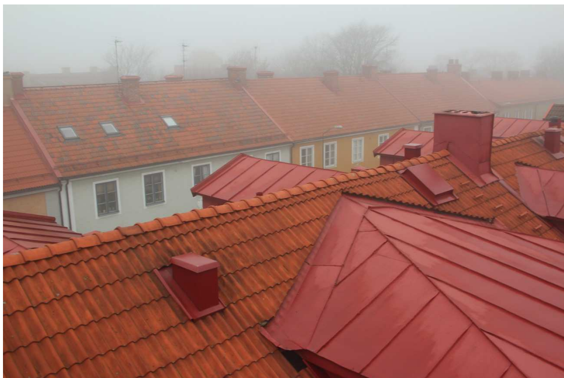
Delar av yttertaket till den aktuella lägenheten
