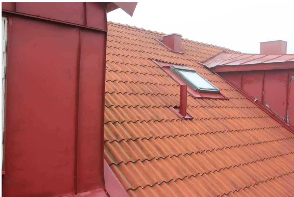
Taket till och fönstret till badrummet i den aktuella lägenheten.
