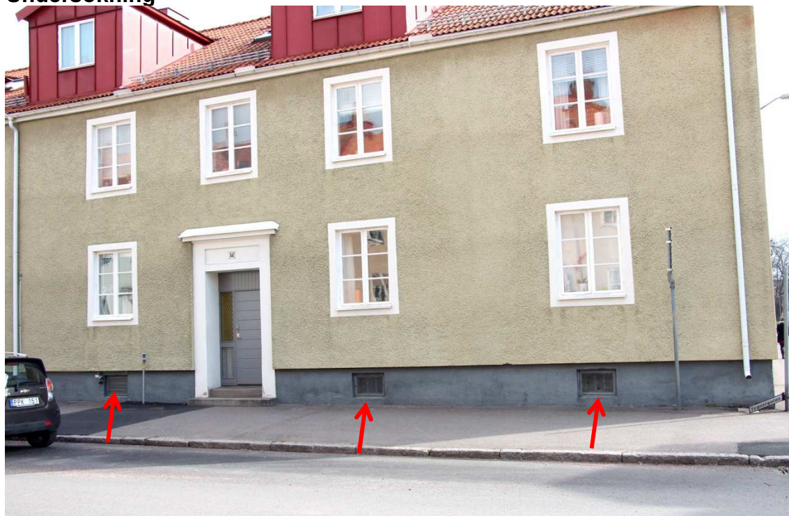
Bild 1. Fastighetens entré vid Tegnérgatan med källarfönster.
