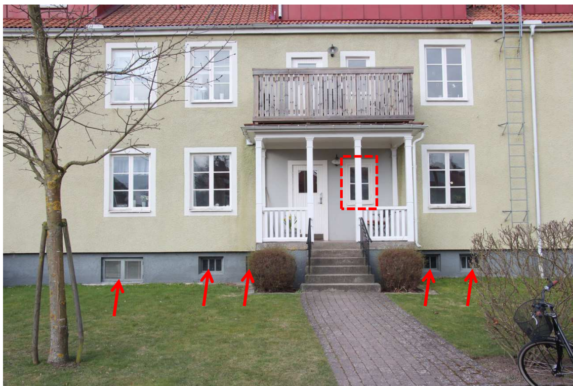
Bild 3. Fastighetens innergård med källarfönster. Markerat fönster vid innergårdens dörr är belägen i trappan, innanför dörren ner till källaren. Fönstret stängs med två fönsterhakar. Fönsterhakarna är hela.
