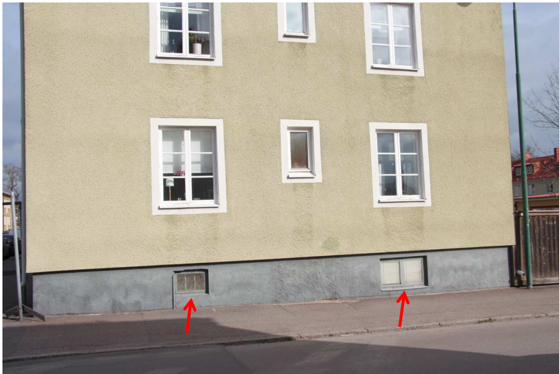
Bild 2. Fastighetens gavel mot Svebiliusgatan med källarfönster.
