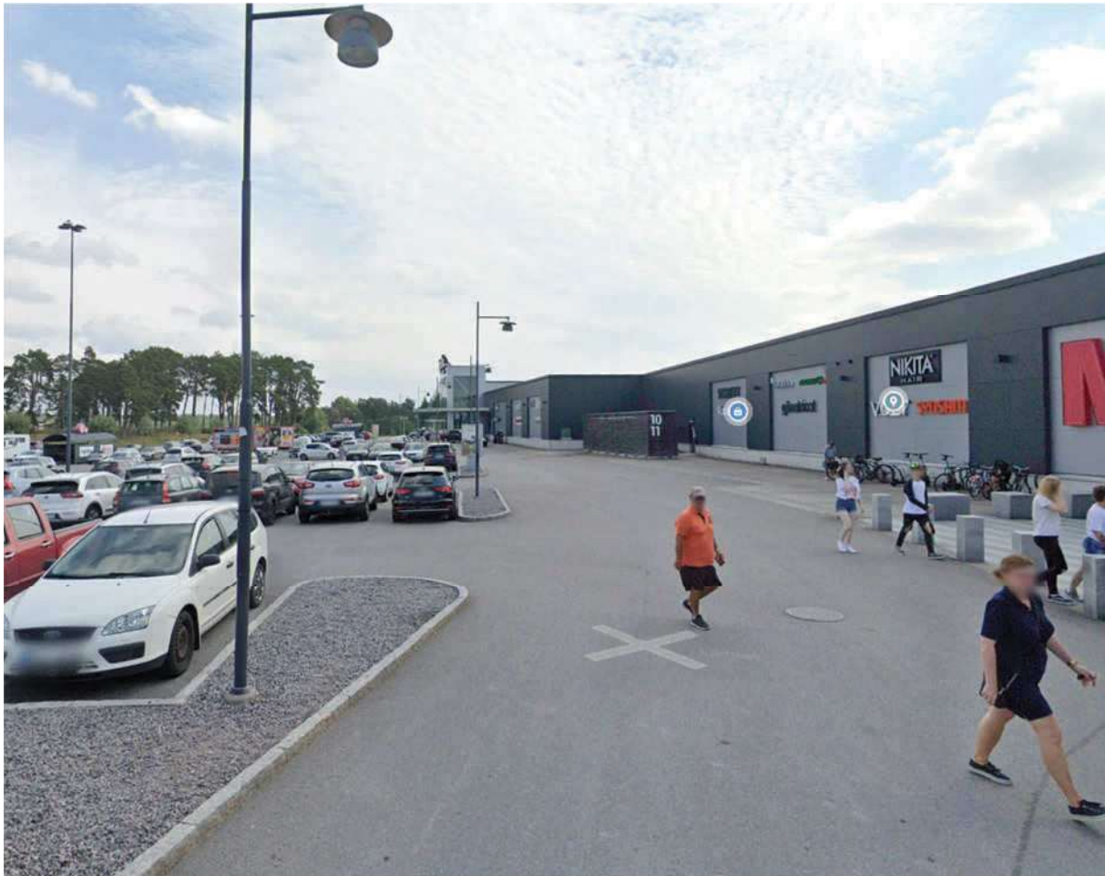
Översiktsbild entrén till Ingesta galleria i östlig riktning från aktuella koordinater.
