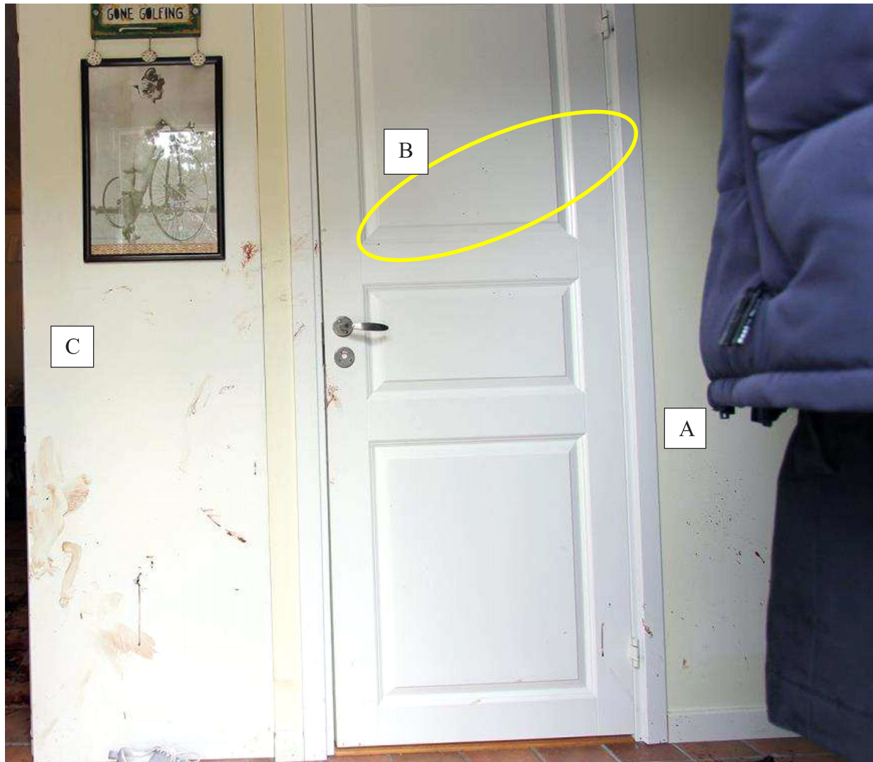
Figur 3. Badrumsdörren och väggarna till höger och vänster om dörren (IMG_7059.JPG)
