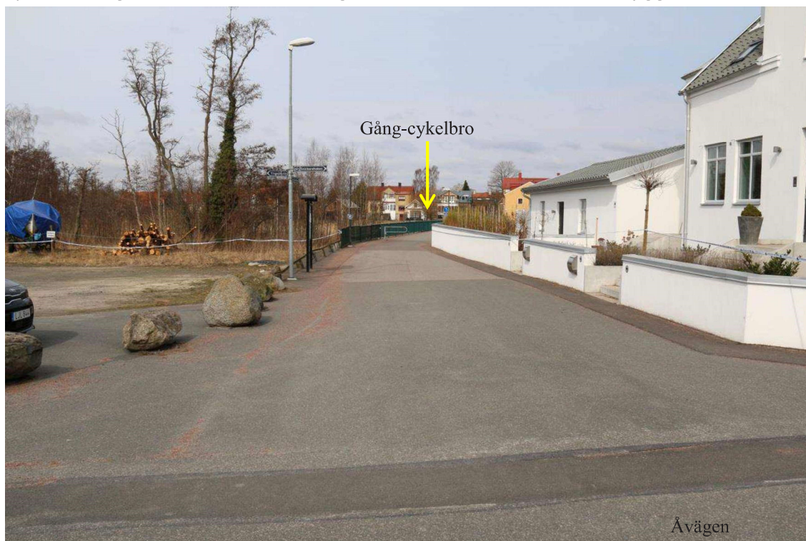
Figur 5. Markeringen visar gång – cykelbron. Till vänster om gång- cykelbron i bilden finns en stig ned till ån.
