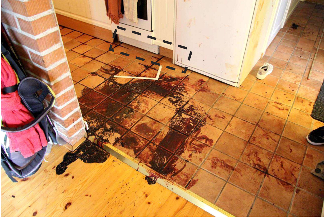
Figur 7. Köksgolvet (IMG_7092.JPG). Streckad markering, se vidare figur 9 .
