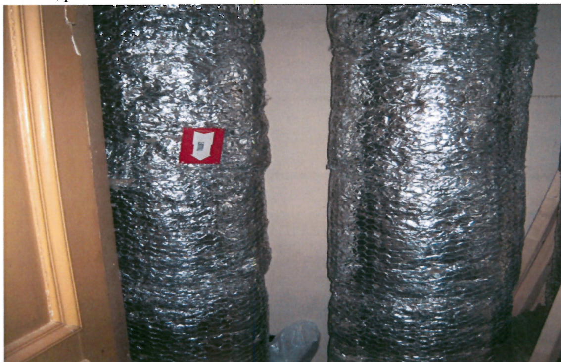
Bild 3. En bild rakt in i det lilla utrymmet. Rören som löper lodrätt. I nedre bildkant skymtar påsarna.
