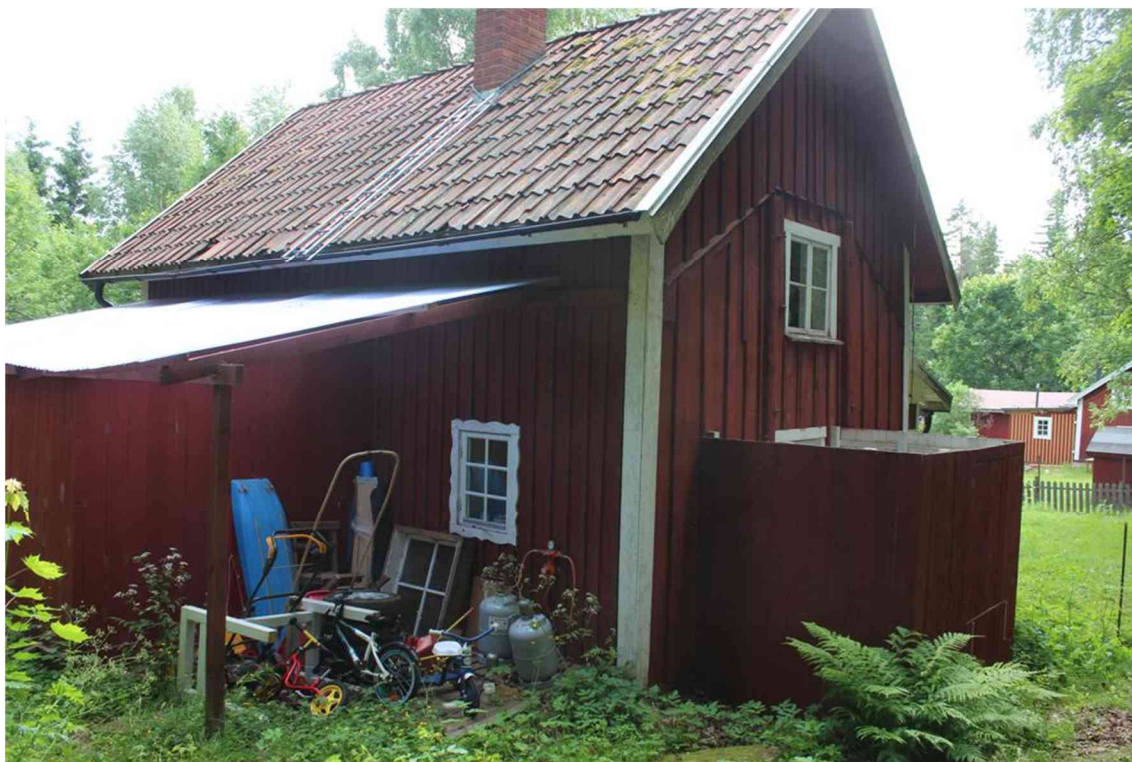
Bild 7. Norra gaveln med tvättrummet under bar himmel.
