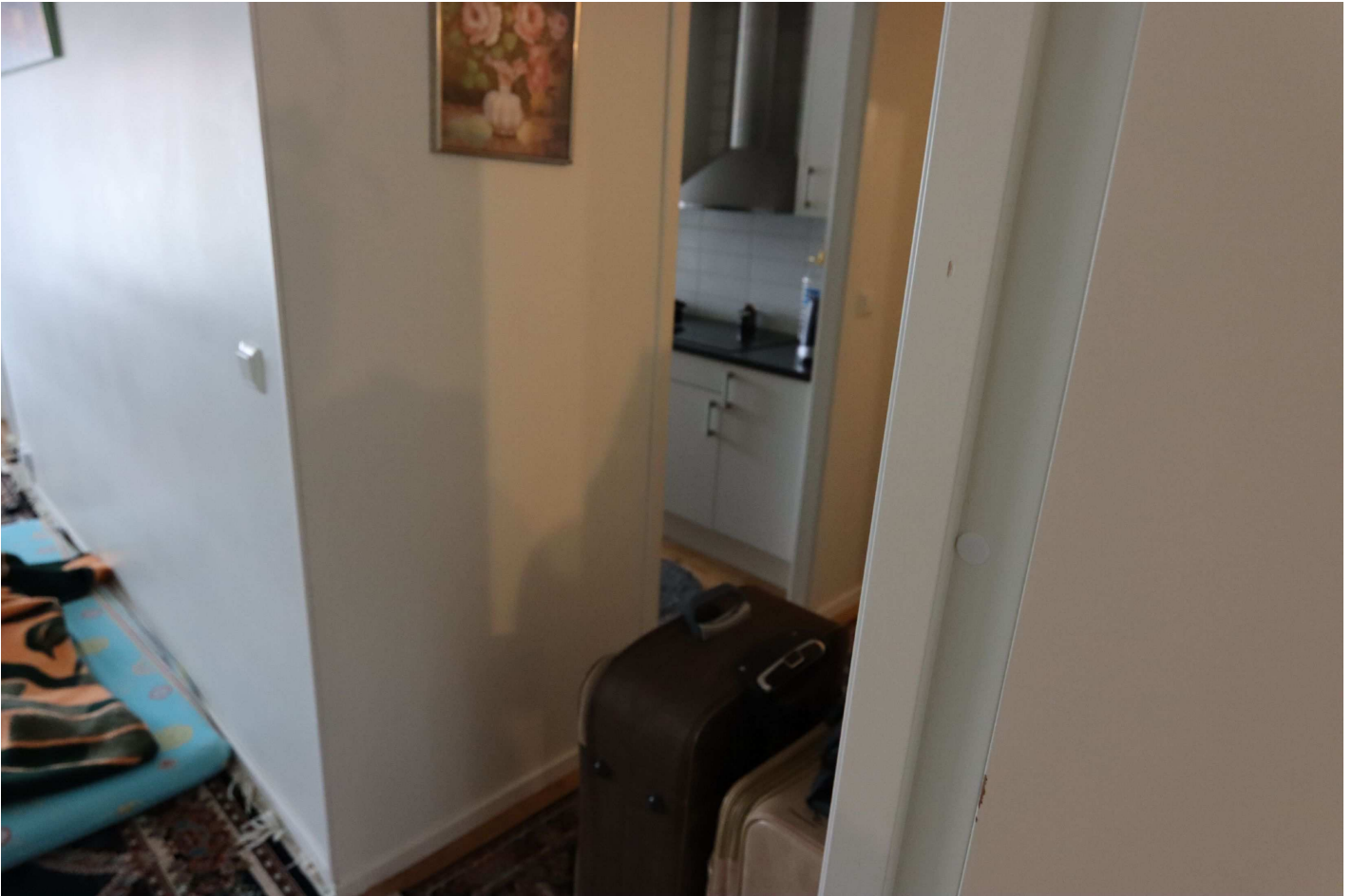
37. Bild tagen från sovrums 3 mot hallen och köket .
