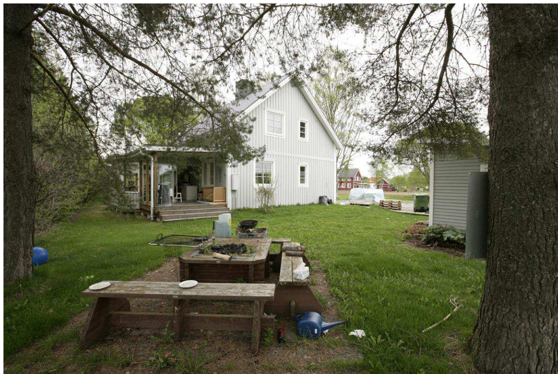
Bild 13 Den södra gaveln och den överbyggda, inglasade altanen på den västra långsidan.
