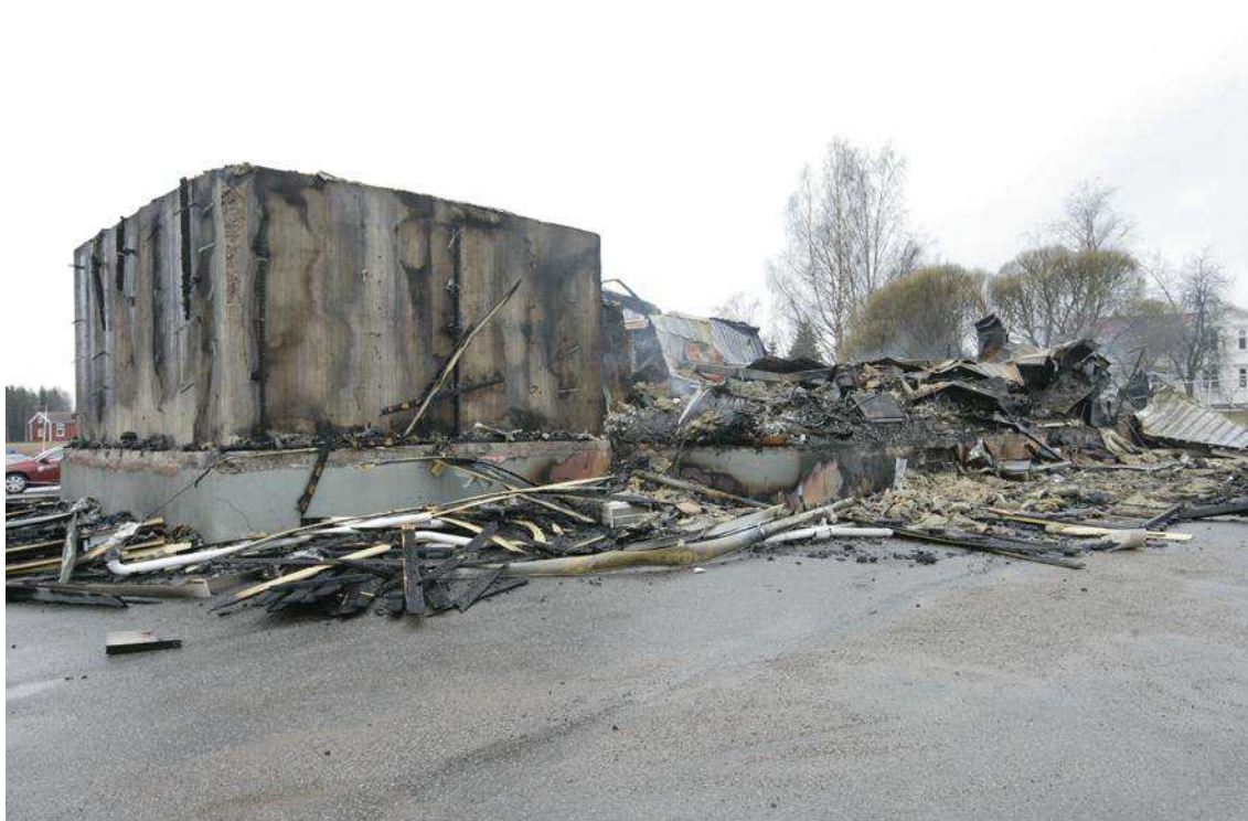
Bild 10 Norra hörnet. Betongkuben som syns i bild är f.d. bankvalvet.
