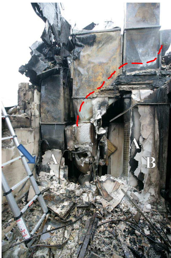
Bild 12 Trapphuset. A markerar gipsvägg mot ventilationsrum. B markerar gipsvägg mot trappförrådet. Streckad markering visar på del av brand-V och blå pil visar på huvudledningen. Röd pil i skiss visar fotoriktning.
