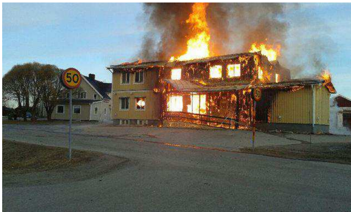
Bild 2 Fastighetens sydöstra långsida (framsidan) fotograferad av räddningstjänsten i ett tidigt skede.
