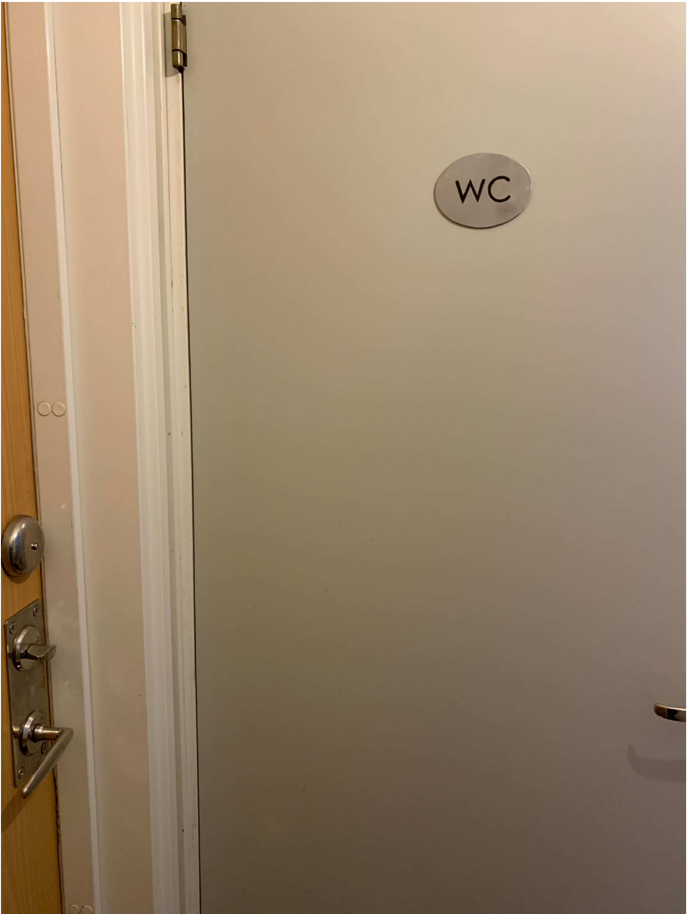
20. Foto taget på dörren till toaletten. Till vänster syns entrédörren till lägenheten.
