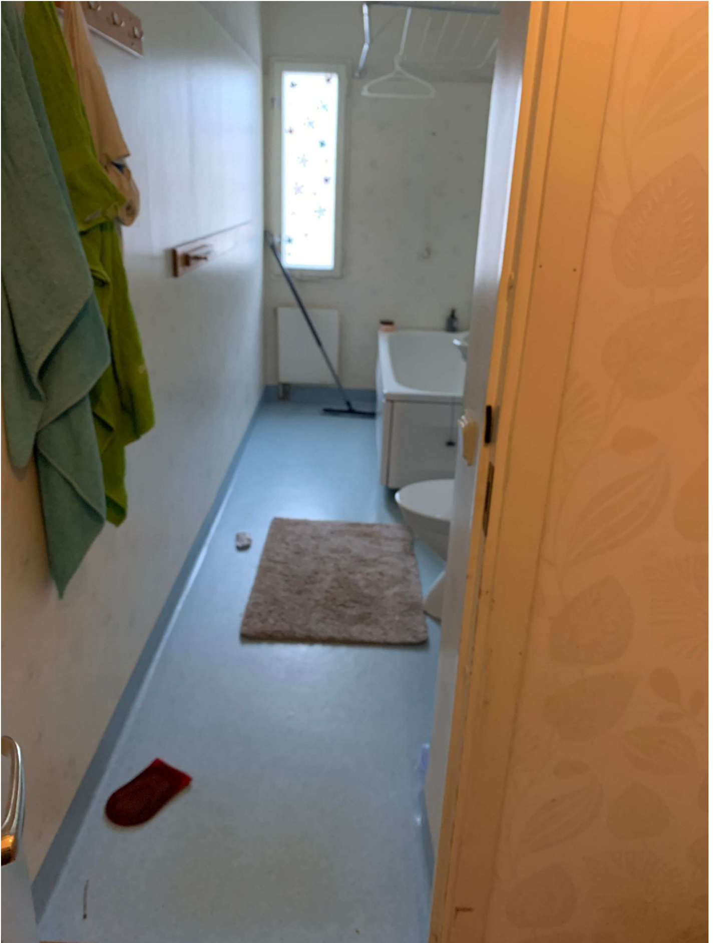
21. Översiktsbild över toaletterummet. Rummet finns direkt till vänster sett från entrédörren.
