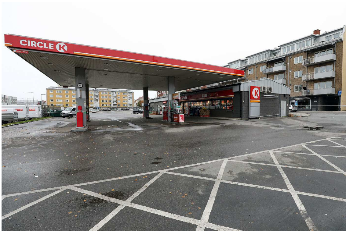
Bild 4. Pumpområde utanför entrén.
