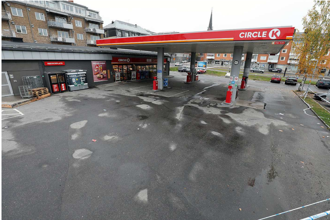
Bild 3. Pumpområde utanför entrén.
