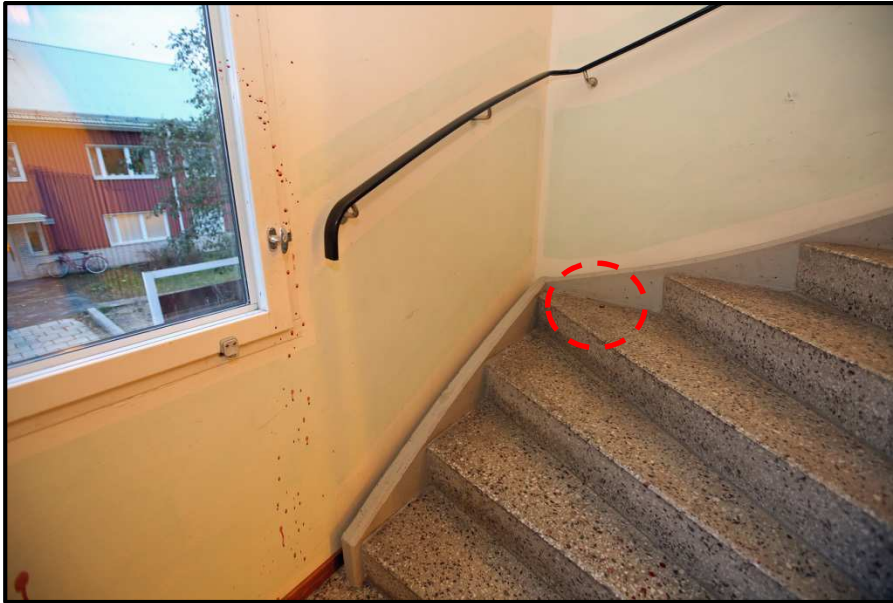
Bild 9. Trappa till vindsvåning.
