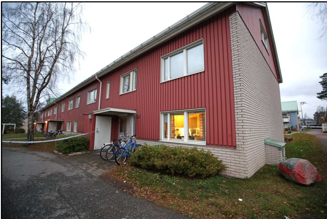
Bild 2. Blåmesgränd 11 östra Gavel. Byggnaden hade tre ingångar. Fasad av tegel och plåt. Byggnaden innehöll lägenheter på tre plan. Den aktuella lägenheten fanns på vindsplanet, östra gavel.
