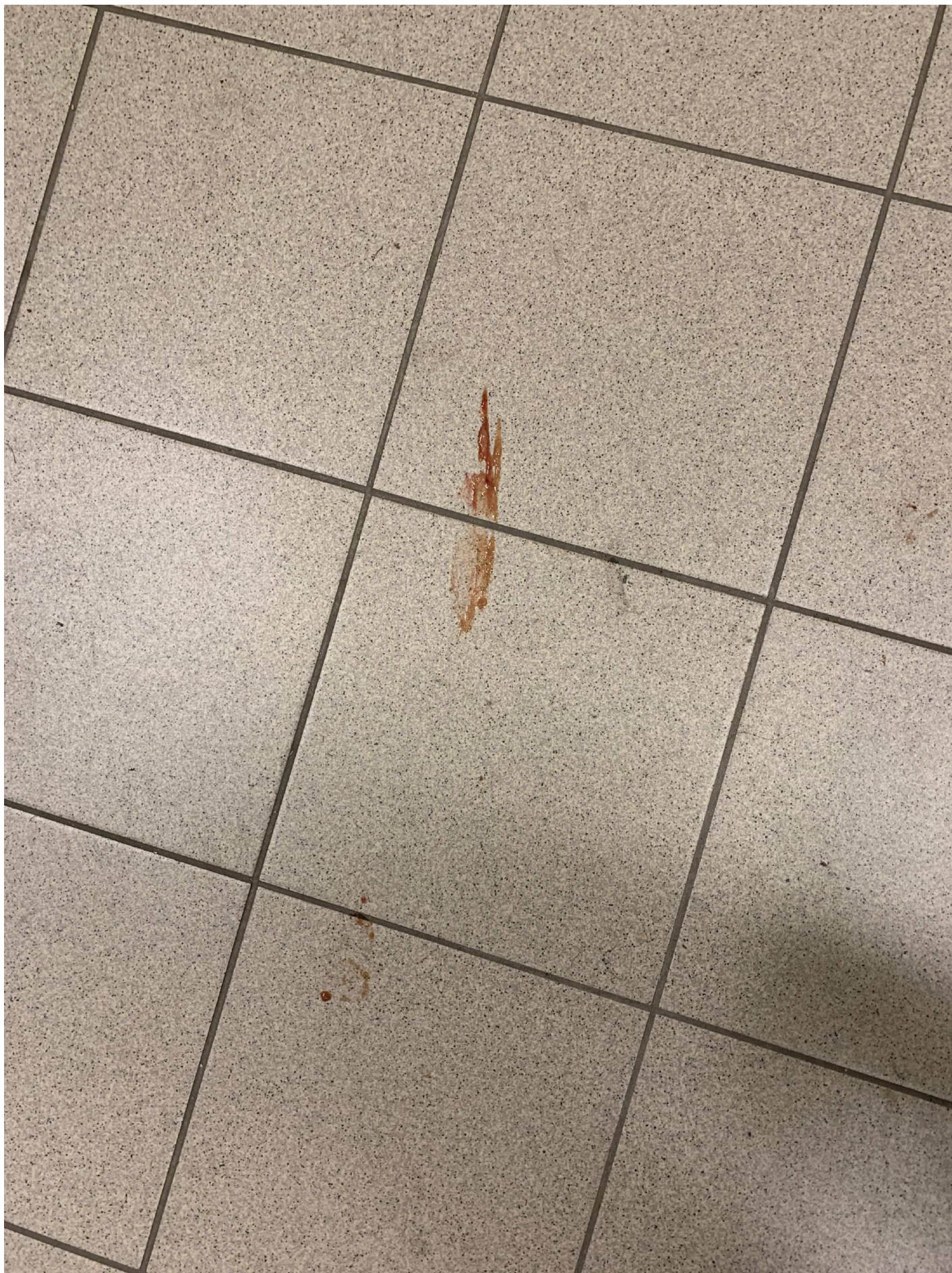
5. Bilden visar misstänkt blodspillning på golvet inne i väktarrummet. Bilden är tagen av PA E Edman. 2021-10-11.
