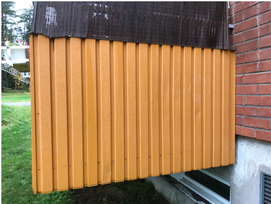
Bild 1: Plåtklädda balkongräcken utan synliga brister/skador.
