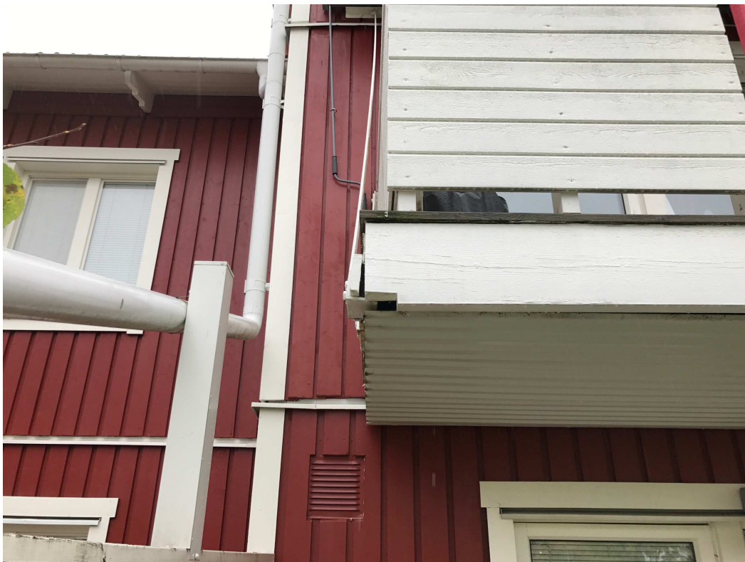
Bild 93: Dragstag infästning skevar, sprickbildning i främre fäste
