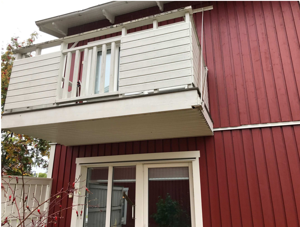
Bild 94: Dragstag infästning skevar
