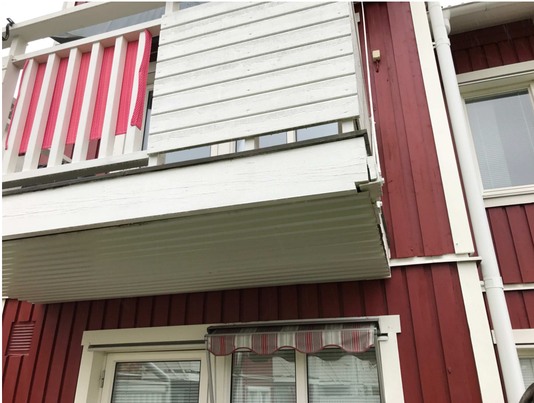
Bild 92: Dragstag infästning skevar, sprickbildning i främre fäste
