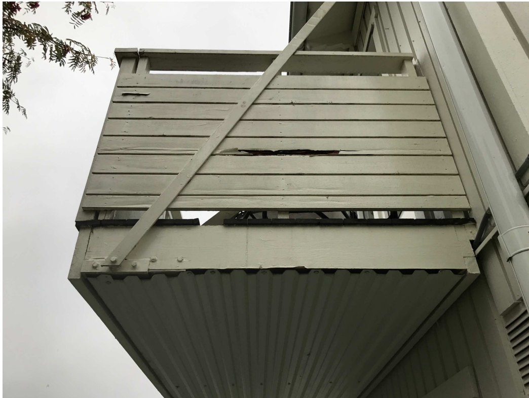
Bild 50: Fuktskadat räcke
