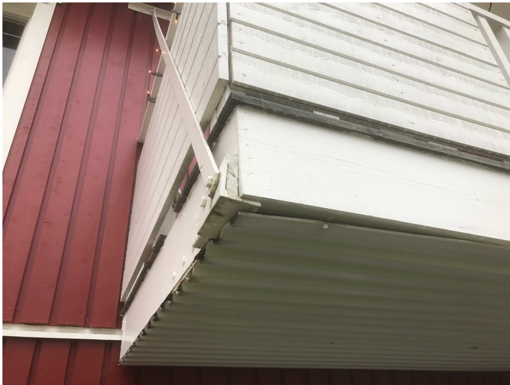
Bild 10: Glipor i främre infästningen av dragstaget
