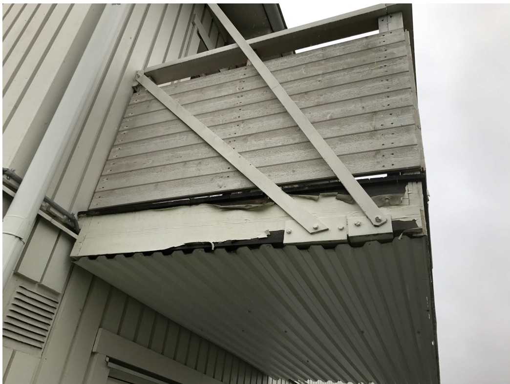
Bild 65: Fuktskadade balkar
