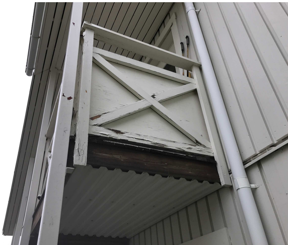
Bild 62: Fuktskadade räcken
