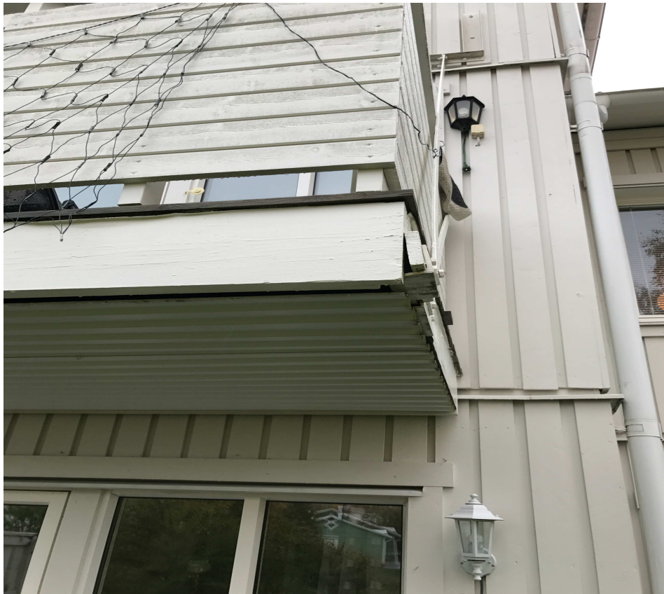
Bild 86: Dragstag infästning skevar
