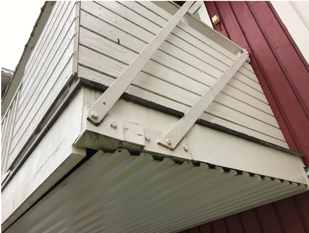
Bild 90: Sprickbildning i främre fäste
