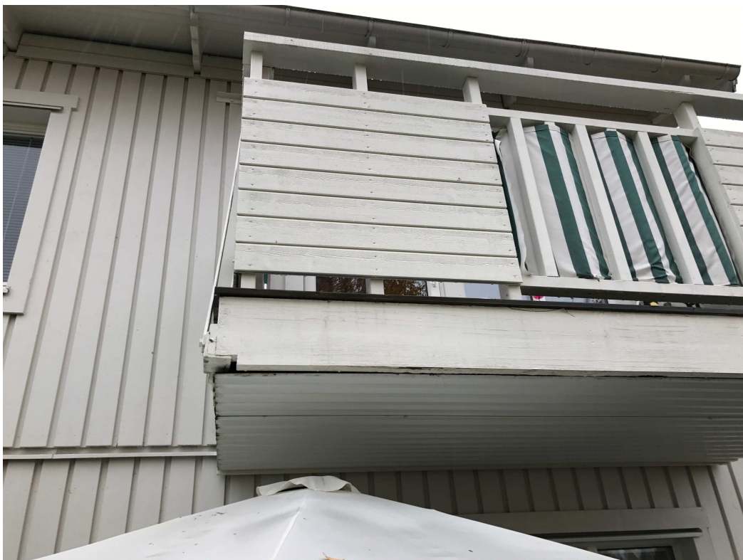
Bild 85: Dragstag infästning skevar
