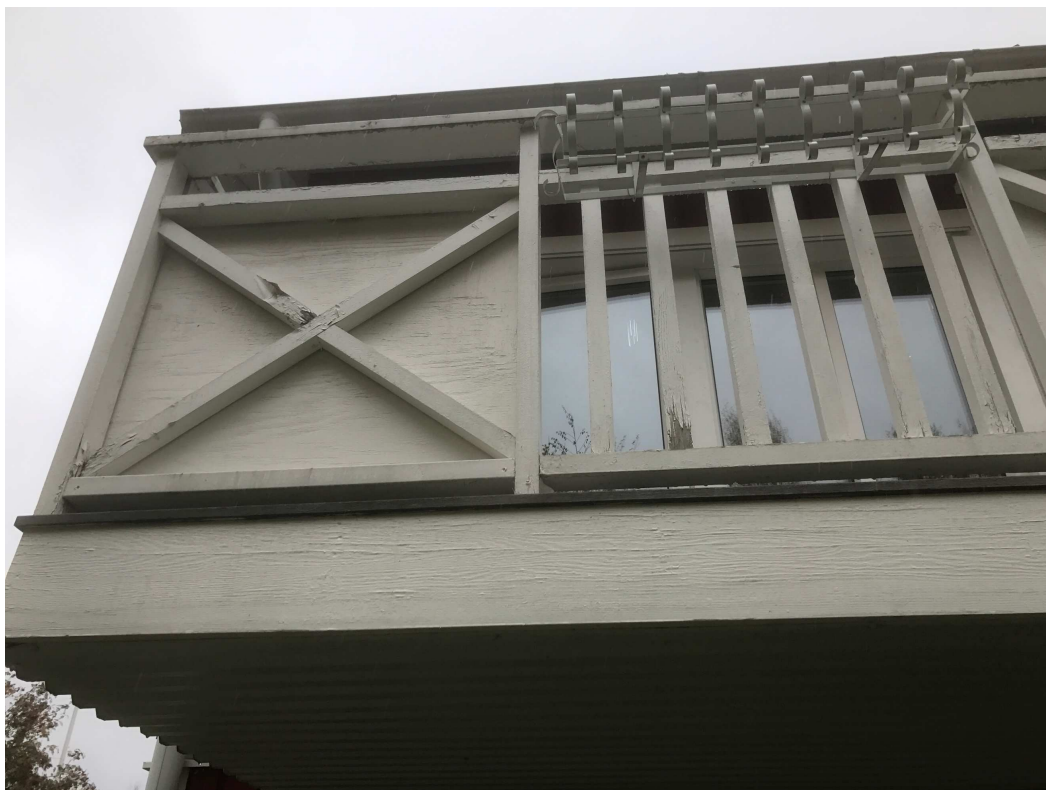
Bild 24: Fuktskadat räcke
