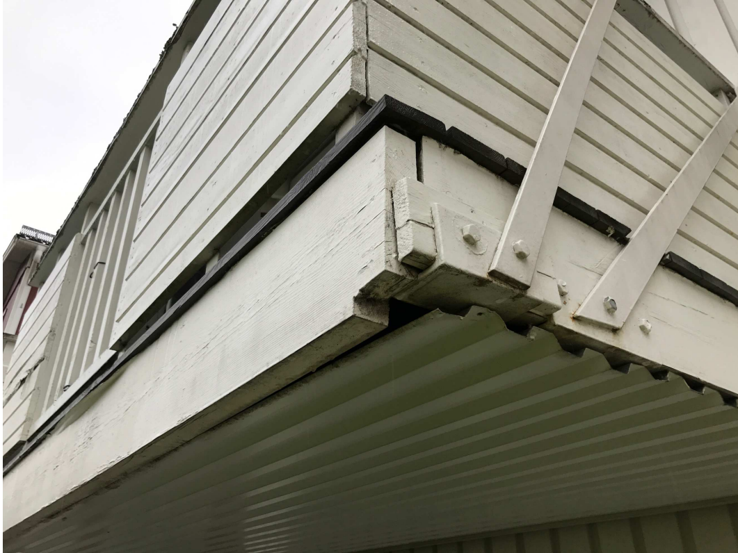
Bild 88: Dragstag infästning skevar, sprickbildning i främre fäste
