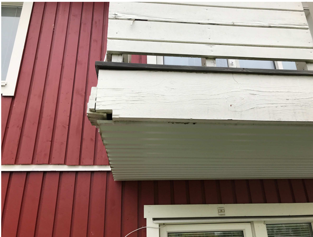
Bild 91: Dragstag infästning skevar, sprickbildning i främre fäste
