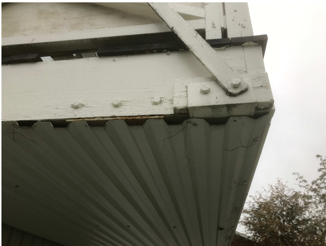
Bild 5: Glipor vid främre infästningen av dragstaget
