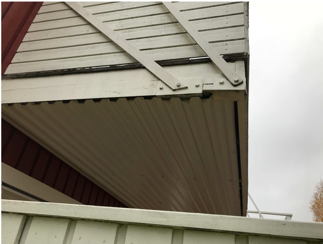
Bild 95: Dragstag infästning skevar, sprickbildning i främre fäste
