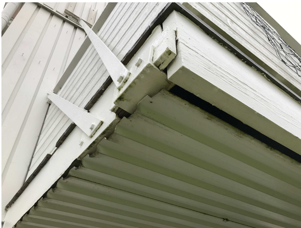
Bild 87: Dragstag infästning skevar
