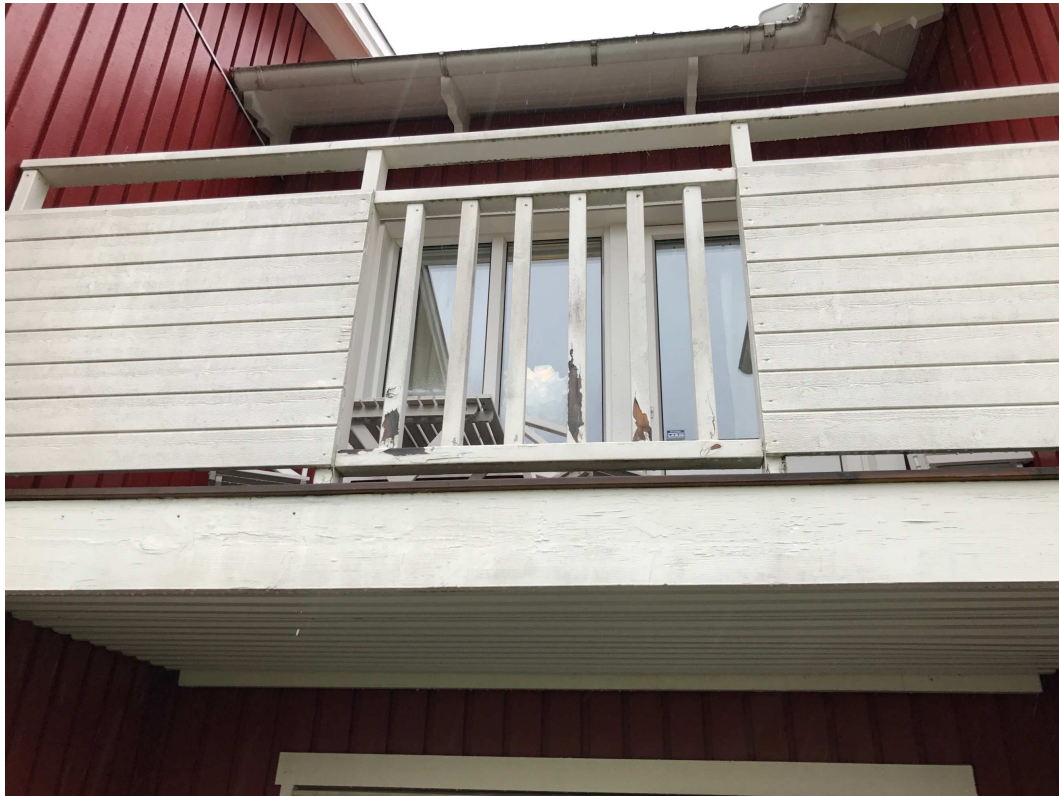
Bild 83: Fuktskadade räcken
