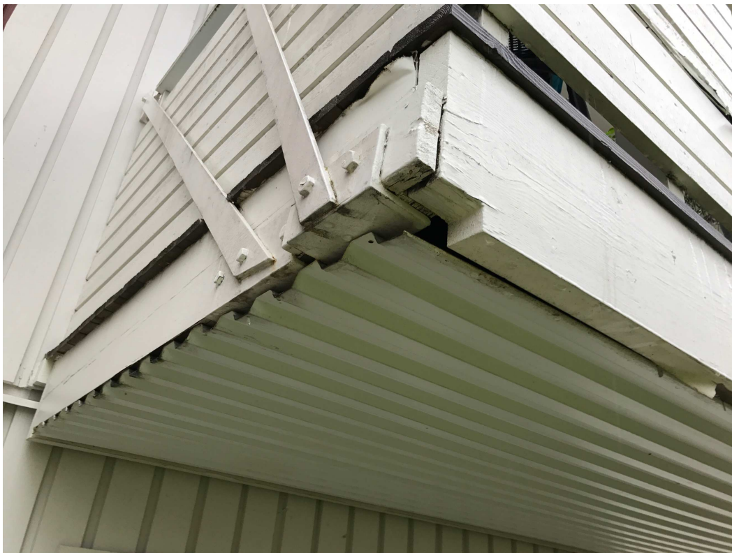
Bild 89: Dragstag infästning skevar, sprickbildning i främre fäste
