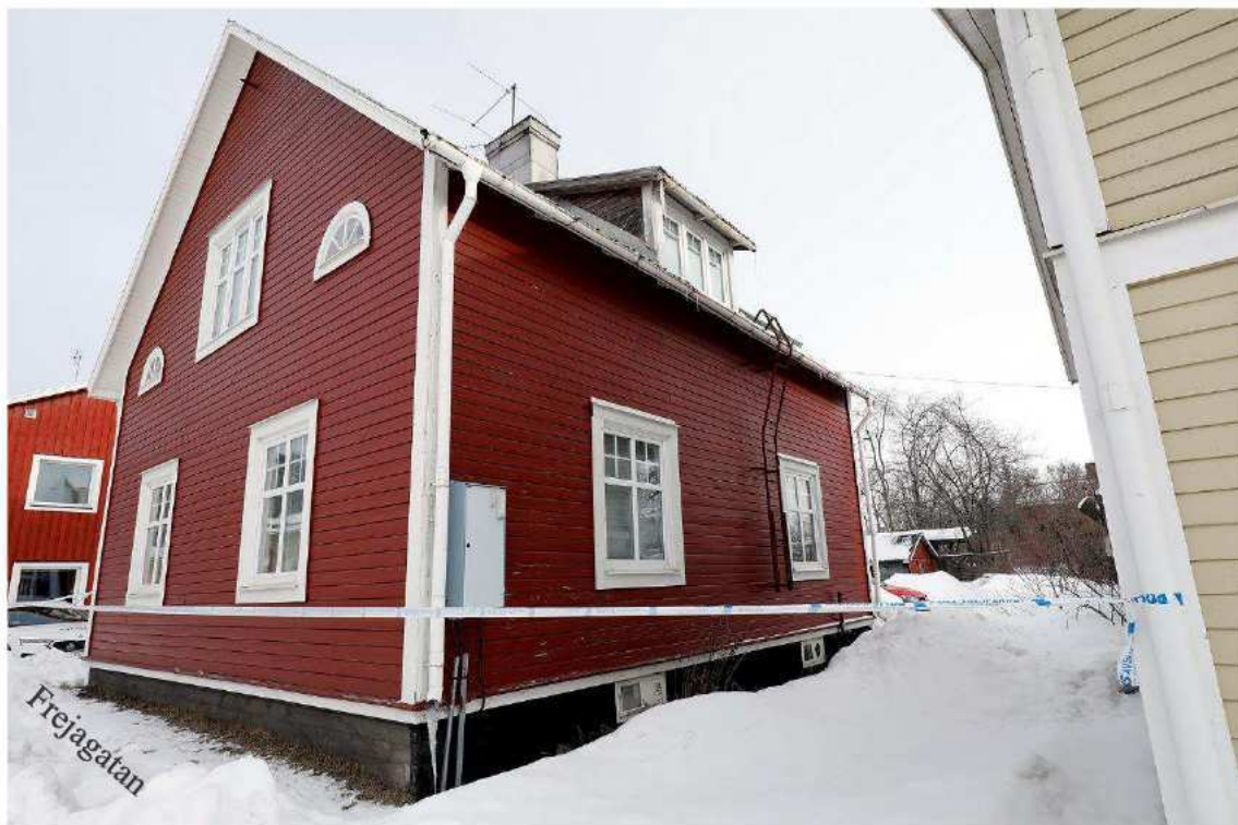
Bild 5. Översiktsbild av villans västra gavel mot Frejagatan och södra sida mot grannfastigheten Frejagatan 22.
