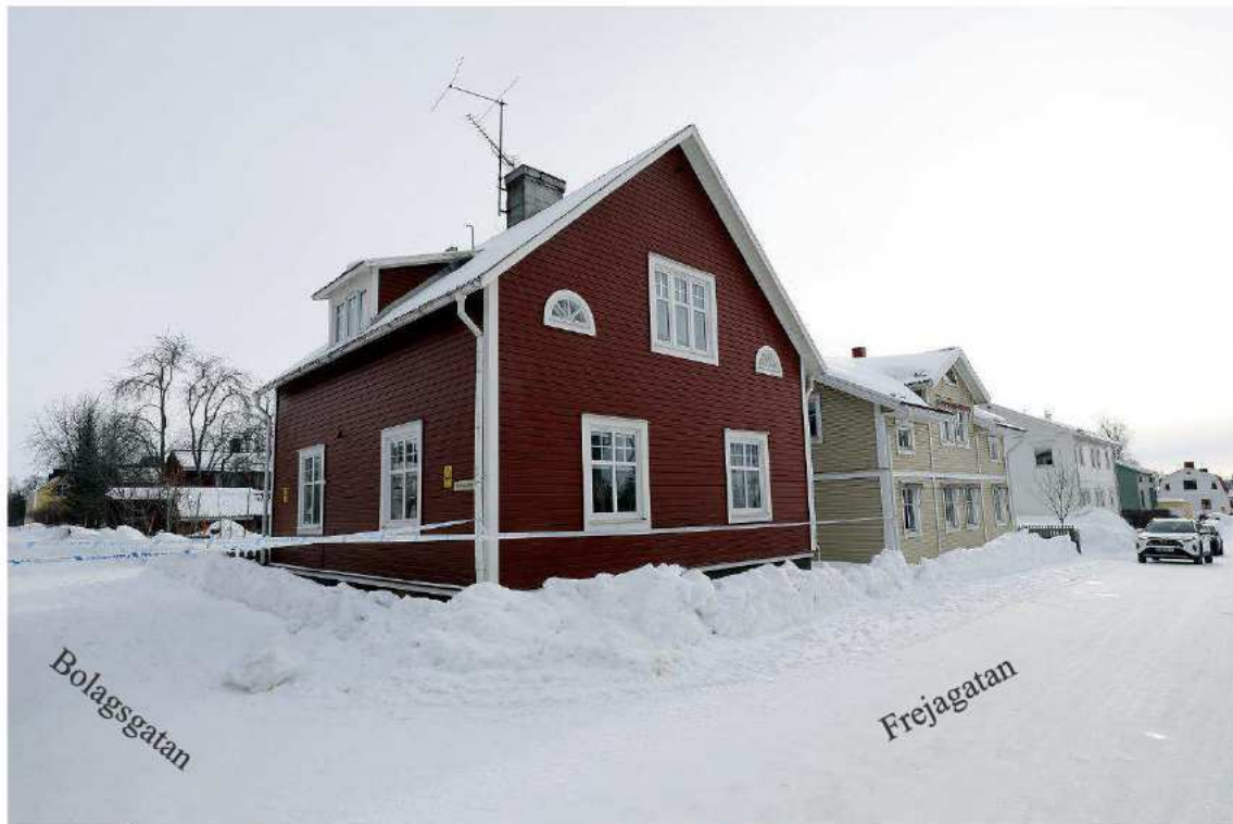
Bild 4. Översiktsbild av villans norra sida mot Bolagsgatan och västra gavel mot Frejagatan. Fotot taget från korsningen Bolagsgatan - Frejagatan.
