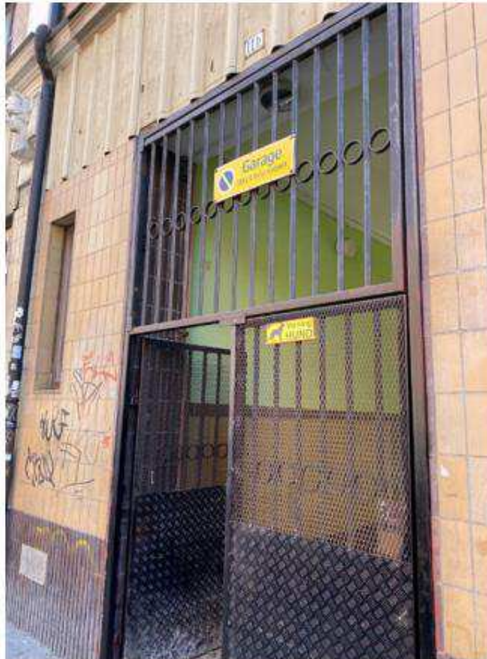
Port Monbijougatan 11B. Leder in till en innergård där man kommer till en dörr till trapphuset tillhörande Bergsgatan 16B.
