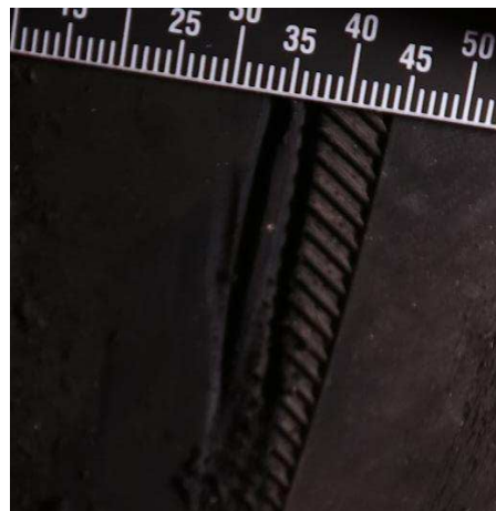
Figur 5. Skada på sida 3.
