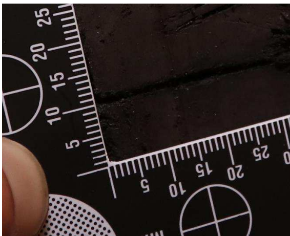
Figur 4. Skada på sida 2.
