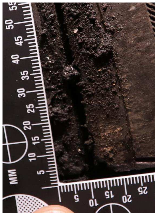
Figur 3. Skada på sida 1.
