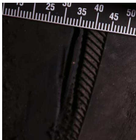
Figur 5. Skada på sida 3.
