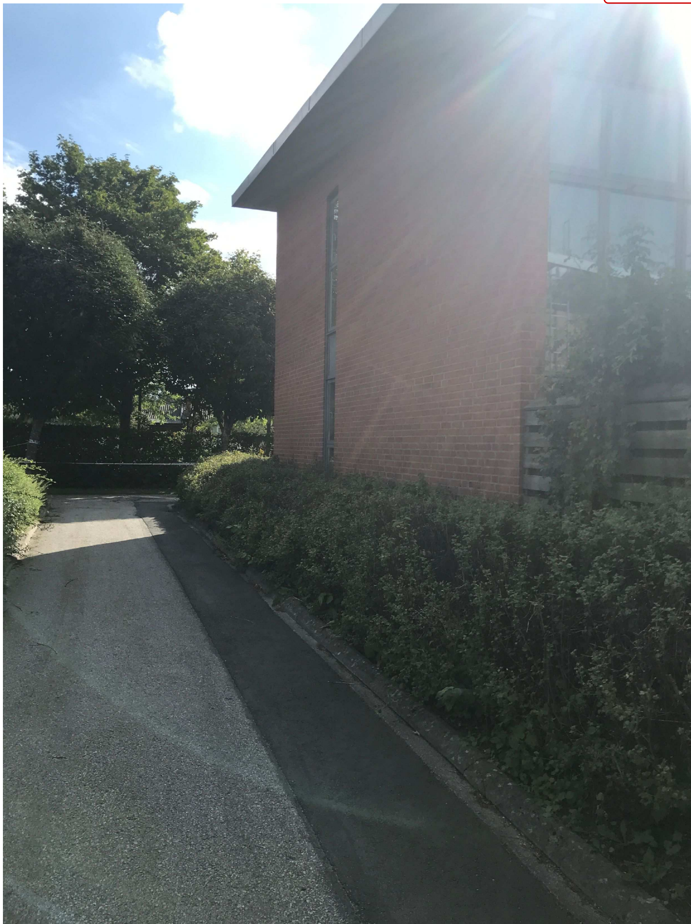
2. Bild på gången mellan huset och parkeringen. Bild tagen av Pa F. Nöjd 2022-08-08. Bild 2
