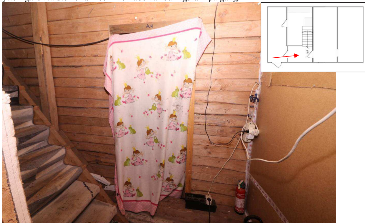
Figur 12. Bakom den uppspikade filten fanns ytterligare två stora rum som verkade var under uppbyggnad för ytterligare odling.
