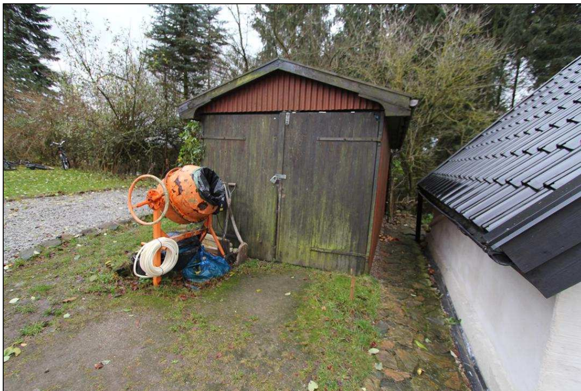
Bild 2. Garaget som var olåst vid tillfället.
