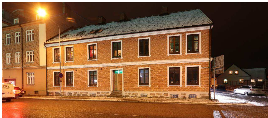
Figur 2. Entrén till Västergatan 13.
