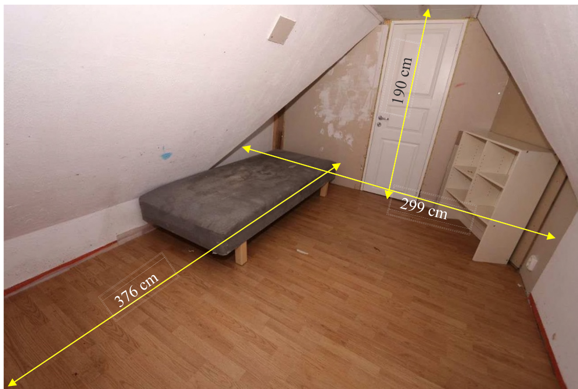
Figur 9. Rummet sett inifrån med stängd dörr. Rummets mått har markerats på bilden av rummet.
