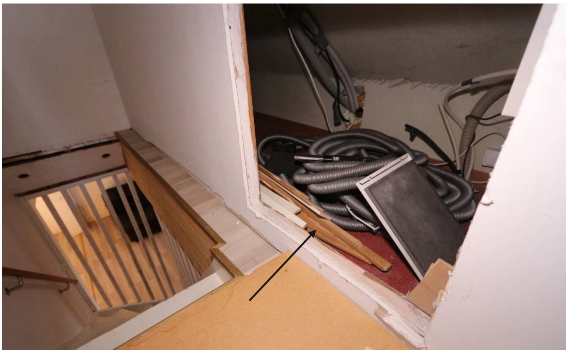
Figur 26. Utrymmet direkt ovanför trappan. Trägrinden har markerats med en pil.
