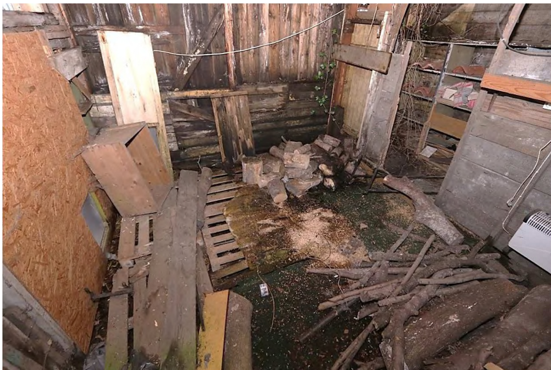
Figur 8. Översikt över det större rummet innanför den högra dörren.
