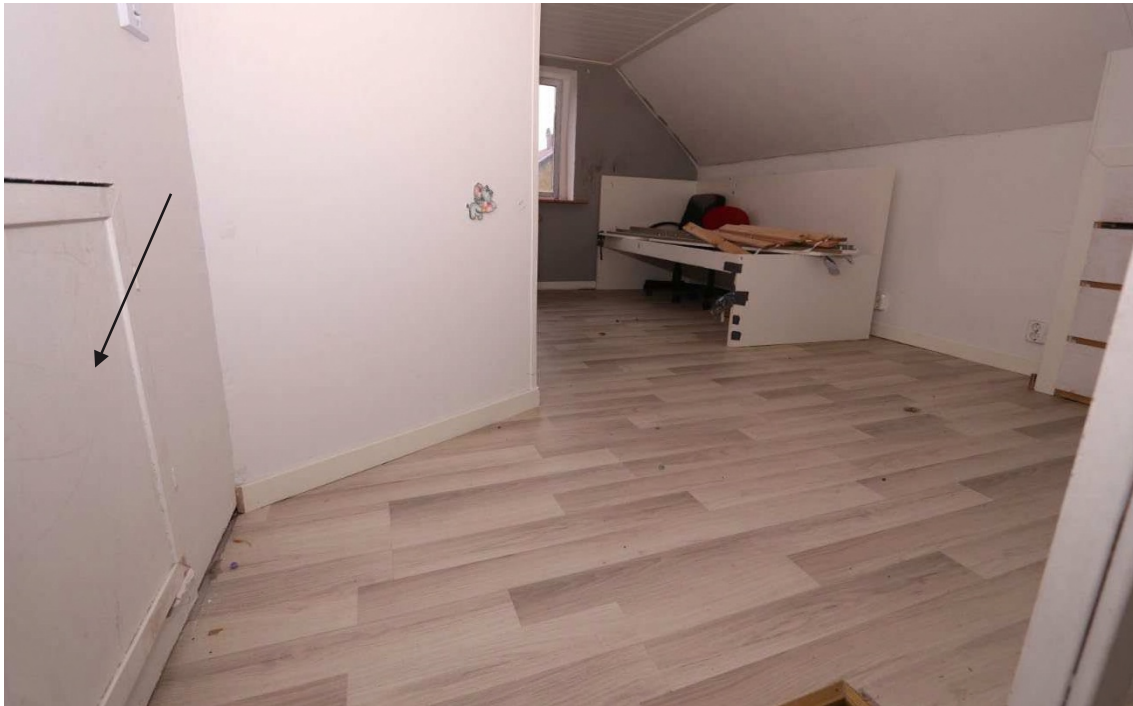
Figur 25. Utrymme vid trappan. En lucka har markerats med en pil.
