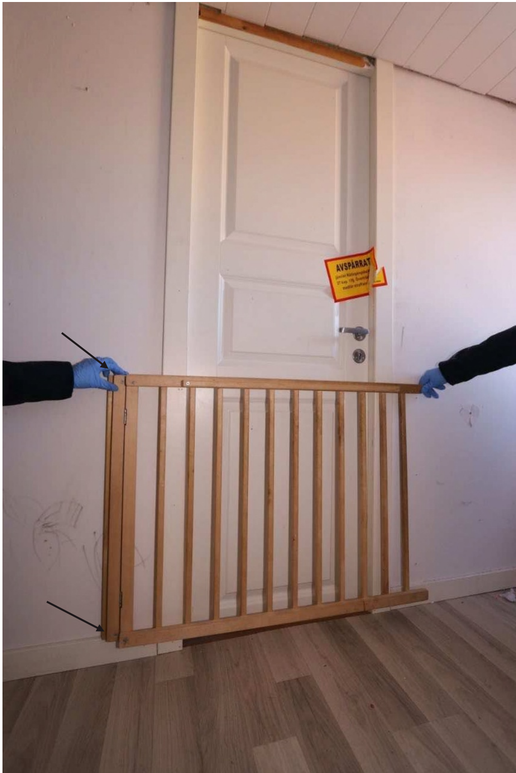
Figur 27. Grinden sammanpassades med skruvhål i väggen, se pilarnas markering.
