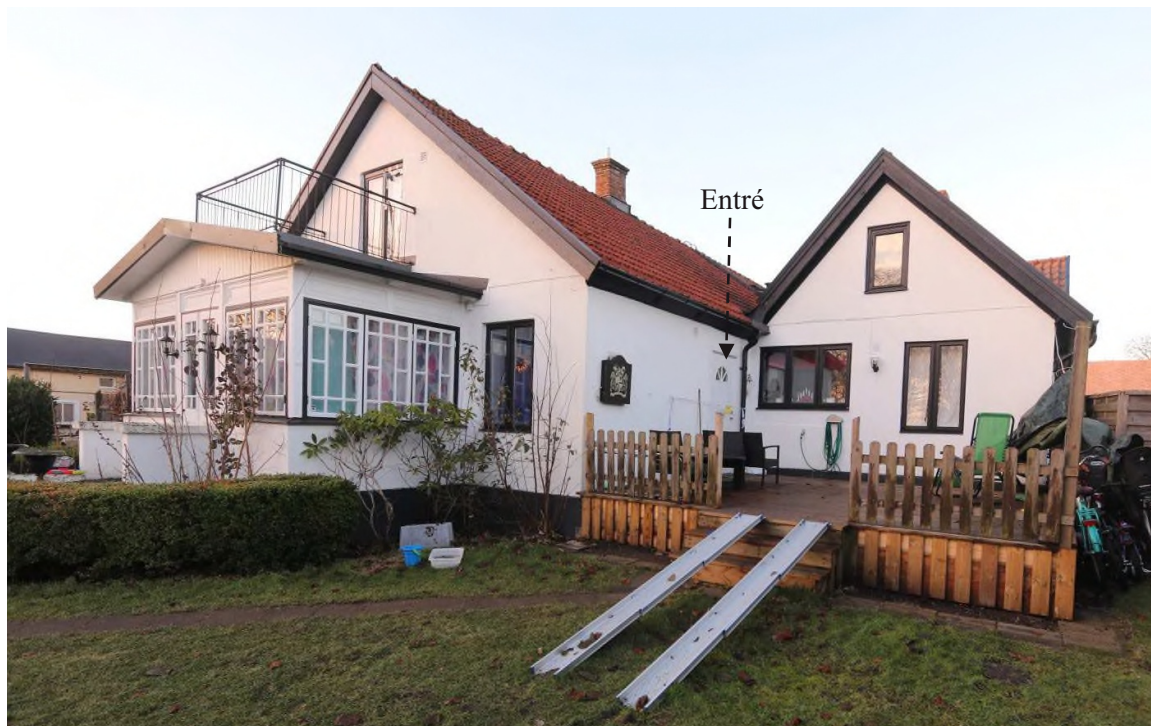
Figur 3. Framsidan och entrén till Storgatan 14 C.
