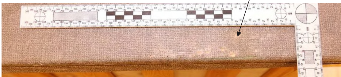
Figur 23. Detaljbild på förslitningsskador på sidan ut mot rummet vid sängben 2.
