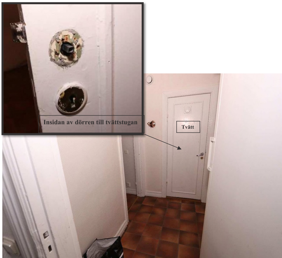
Figur 9. Tvättstugan har markerats med "tvätt". Den infällda bilden är tagen på dörrens insida där det saknades ett handtag
