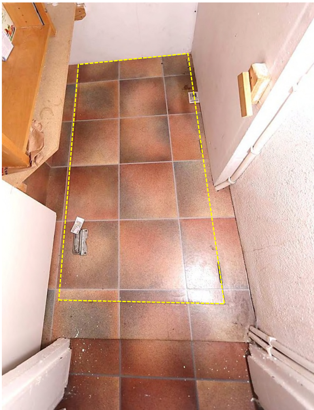
Figur 6. I golvet ses en lucka, markerat med gul streckad rektangel, efter att golvytan i skafferiet tömts på gods.
