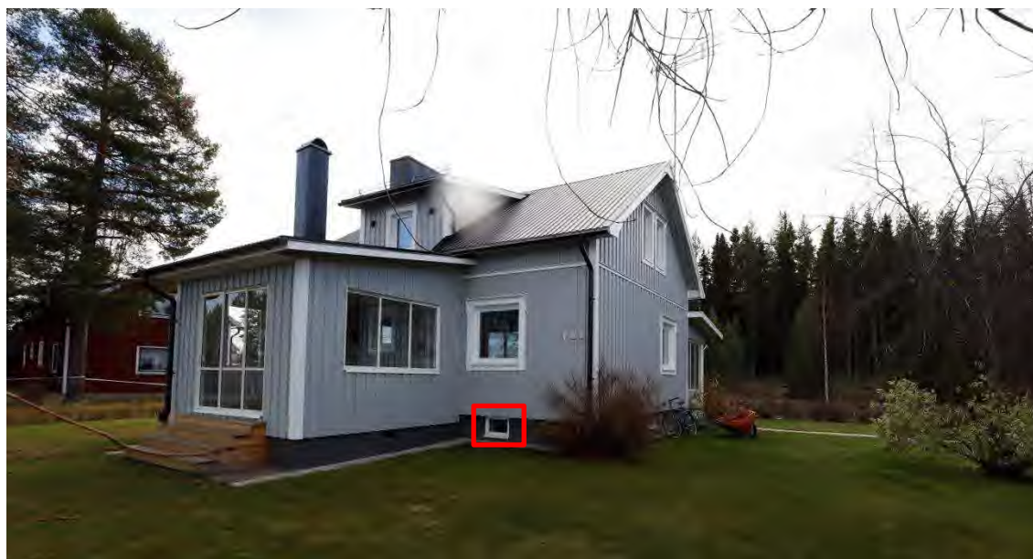
Figur 6. Visar baksidan av bostaden med inglasningen som var olåst. Inne i inglasningen fanns en låst altandörr. Röd markering visar källarfönster där det yttre glasat var trasigt.
