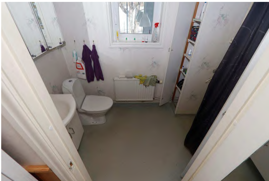
Figur 38. Visar badrummet på nedervåningen.
