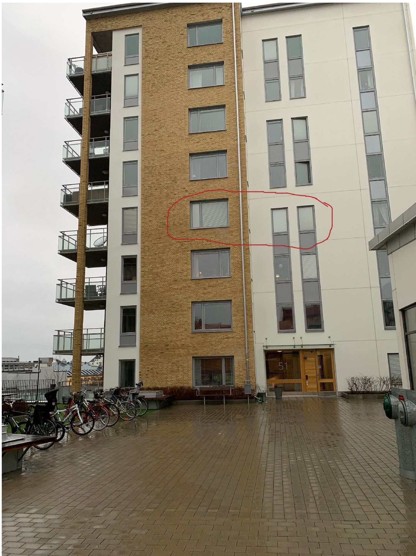
7. Aktuell lägenhet. Fördragna fönster. Det finns ytterligare ett fönster i den gula utbyggnaden. Se gårdsbild.
