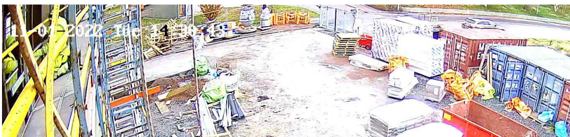
Bild 6. 14:30:43. Mercedes YZH521 stannar och parkerar längs trottoarkant utanför grinden till byggarbetsplatsen.
