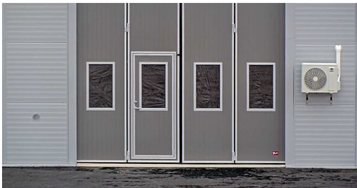
Polisens foto mot lagerlokalen Granitvägen 9D, Värnamo. På portarna återfinns en installerad dörr med nyckellås.
