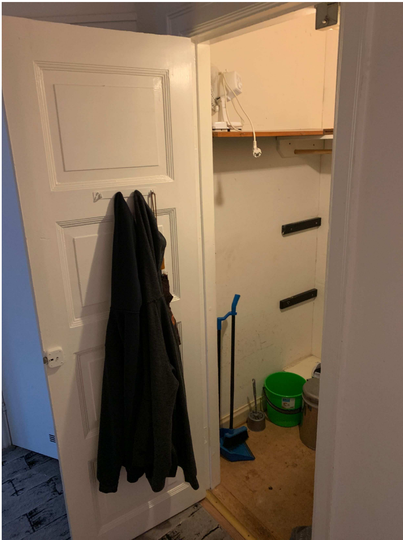
10. Ytterliggare garderob i lägenheten. Inga beslag anträffade.
