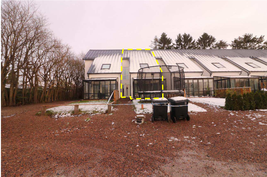
Figur 2. Framsidan av aktuell fastighet. Ankarvägen 22 markerad med gul streckad linje.
