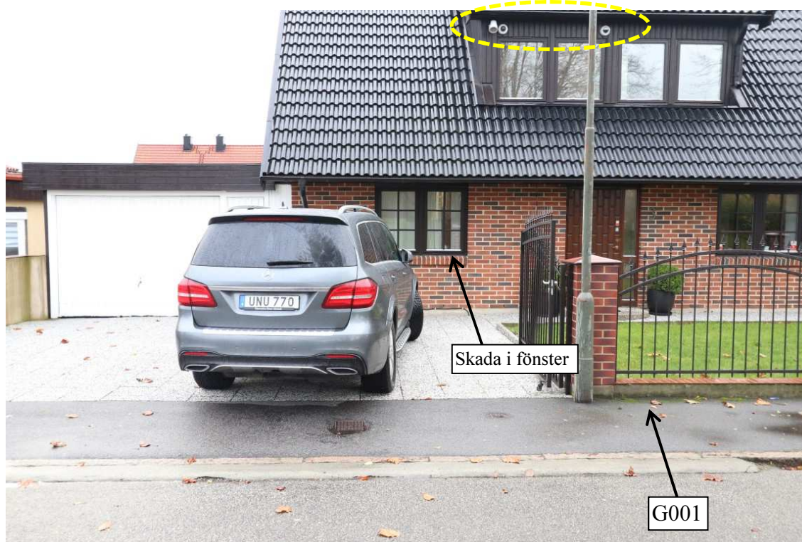
Figur 4. Oxelplanen 3, Malmö. Övervakningskamerorna är markerade med en gul streckad linje.
