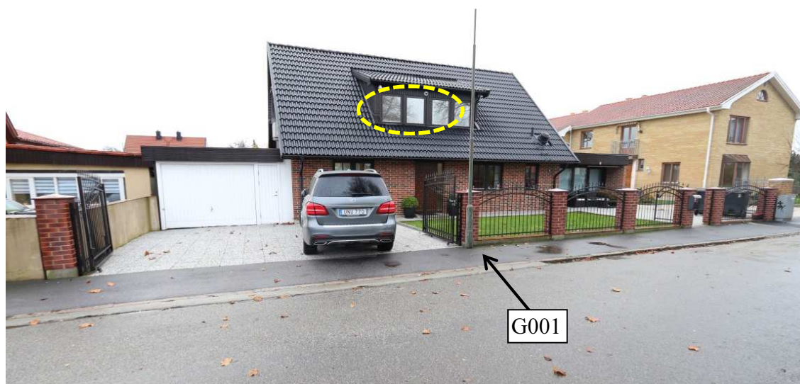
Figur 3. Oxelplanen 3, Malmö. Övervakningskamerorna är markerade med en gul streckad linje.
