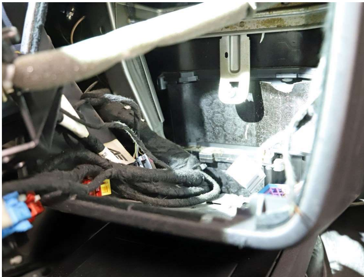
Bild 12. Utrymme bakom/under radiodelen, se pil 3 föregående sida.
