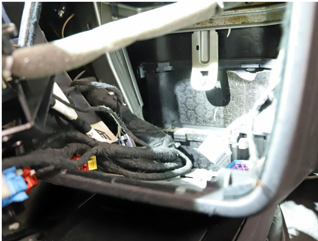
Bild 12. Utrymme bakom/under radiodelen, se pil 3 föregående sida.
