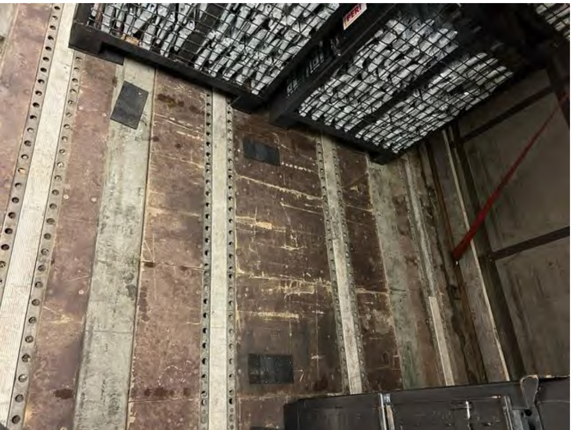
Golvplattor över vaggan efter att en del av lasten avlastats.
