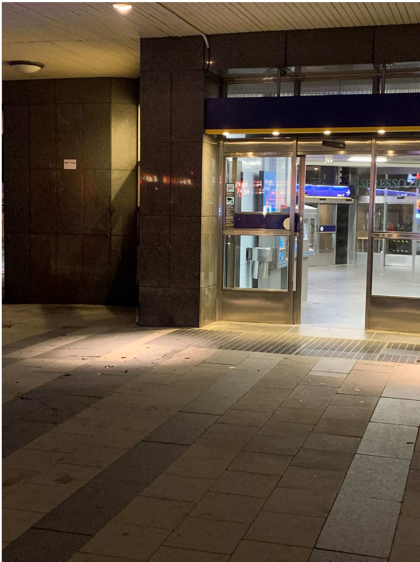
1. Foto på trottoaren utanför biljetthallen tunnelbana Fridhemsplan uppgång Drottningholmsvägen. Glaskross syns på marken.
