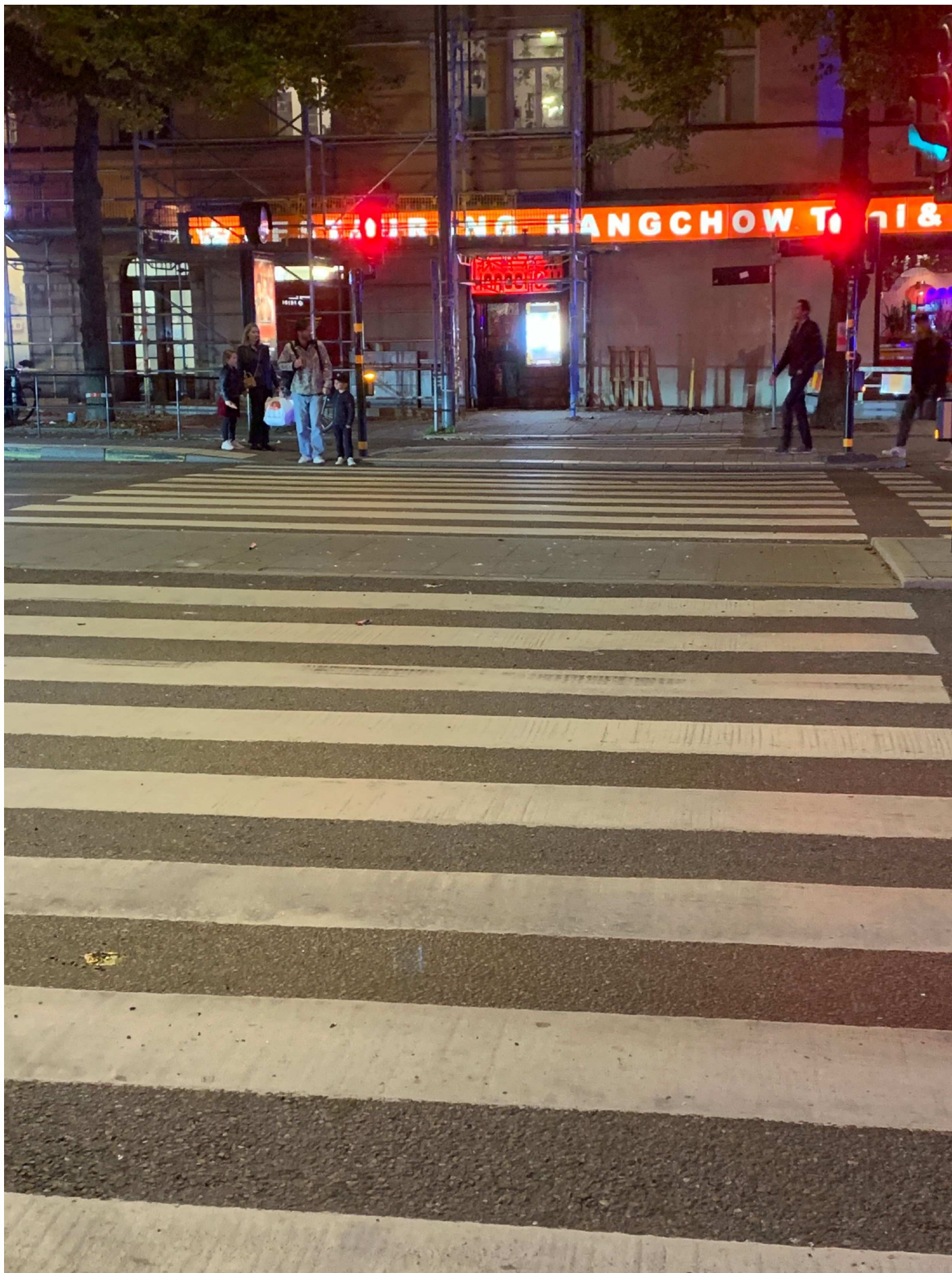
27. Foto korsningen Drottningholmsvägen/Fridhemsgatan. Glaskross syns på marken.
