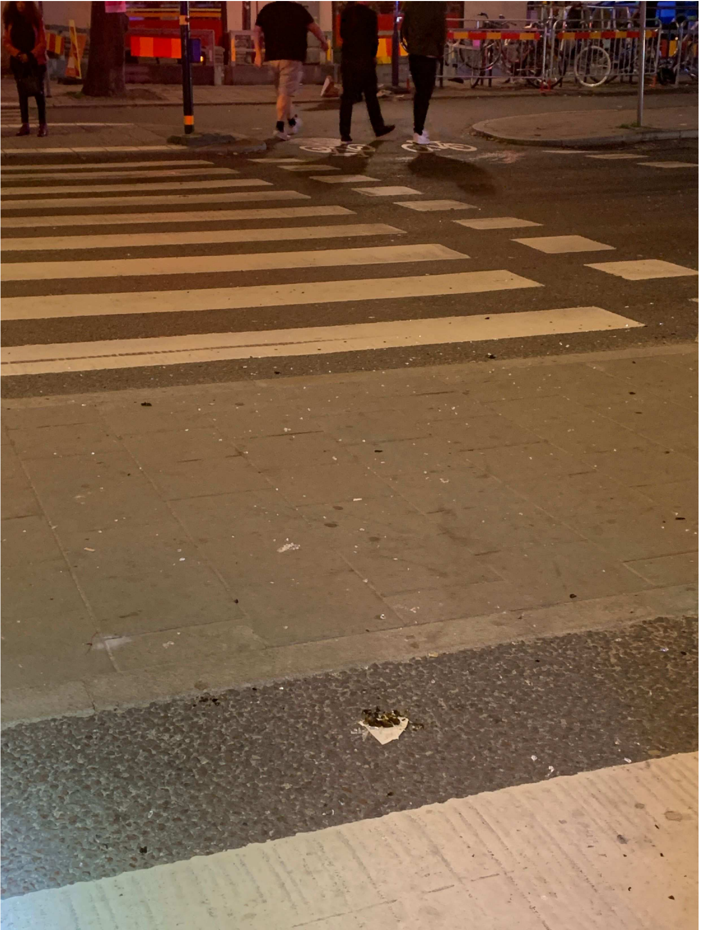
35. Foto korsningen Drottningholmsvägen/Fridhemsgatan. Glaskross syns på marken.
