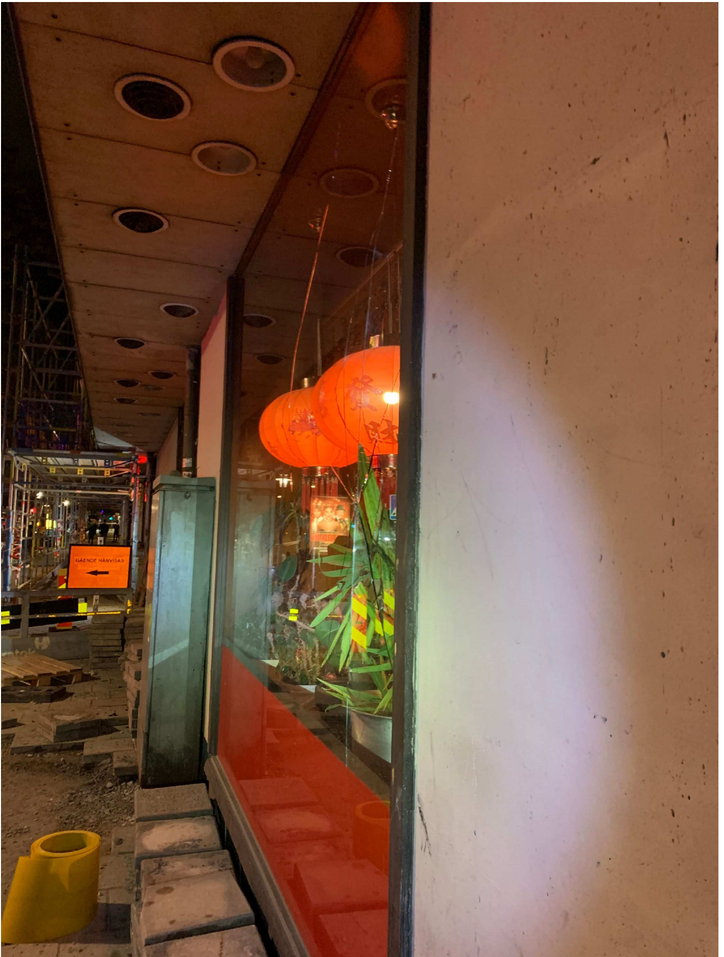
11. Bild på skadad fönsterruta restaurang Hang Chow.
