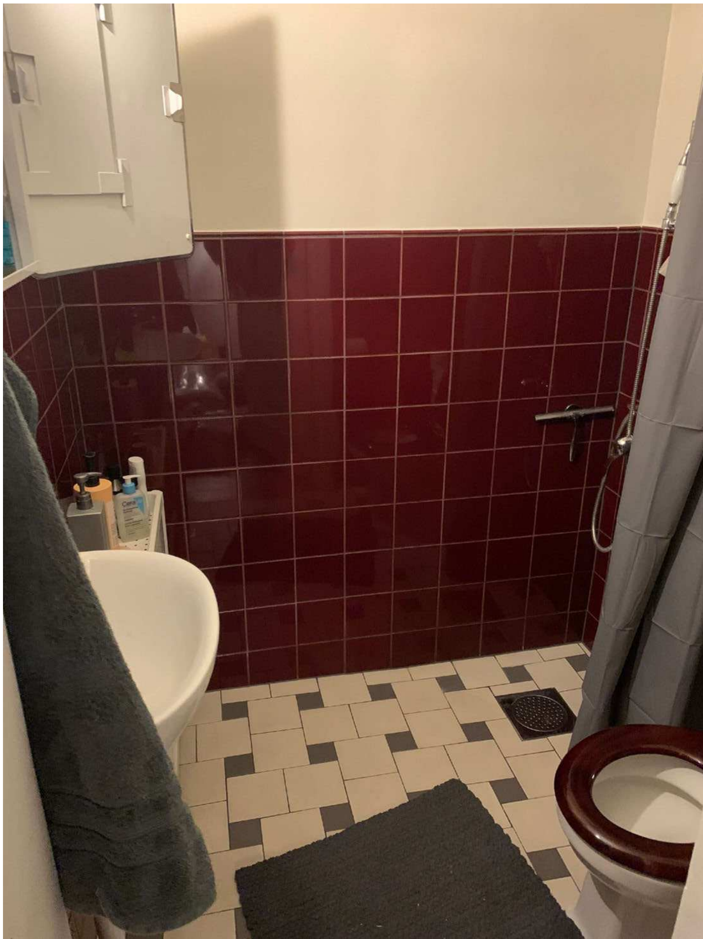
3. Översikts bild: Östervärnsgatan 16C. Toaletten.
