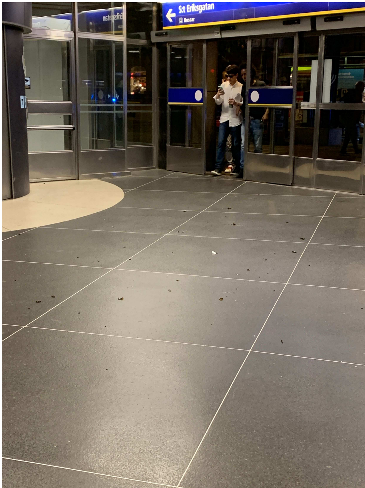
8. Foto inne i biljetthallen tunnelbanan Fridhemsplan. Glaskross syns på golvet i biljetthallen.
