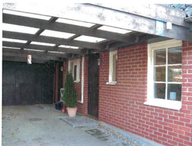
Garaget längst till vänster. Entrédörren till huvudingången närmast till höger. Dörren längst bort i hörnet är groventrén. Det lilla fönstret till höger om dörren leder in till trappan till ovanvåningen
