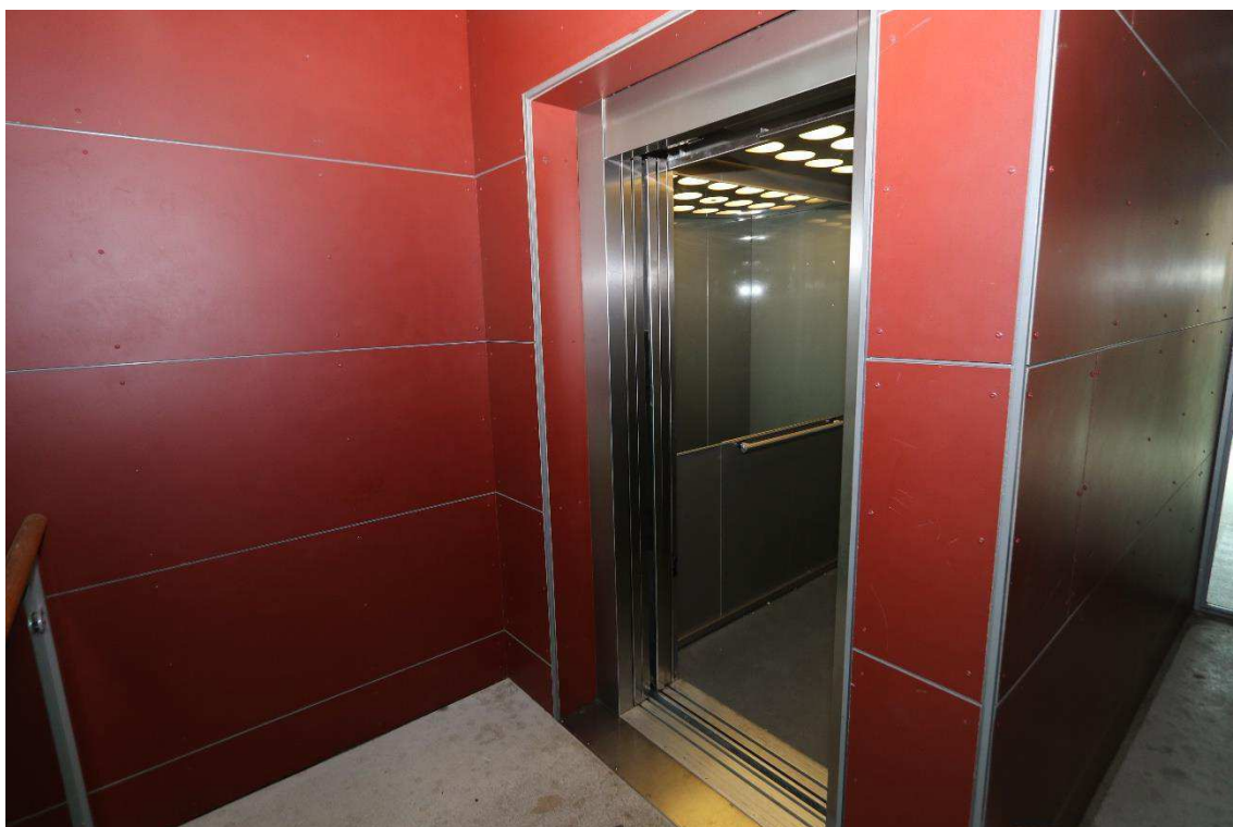
Figur 9. Hissen var uppställd på våning 3.
