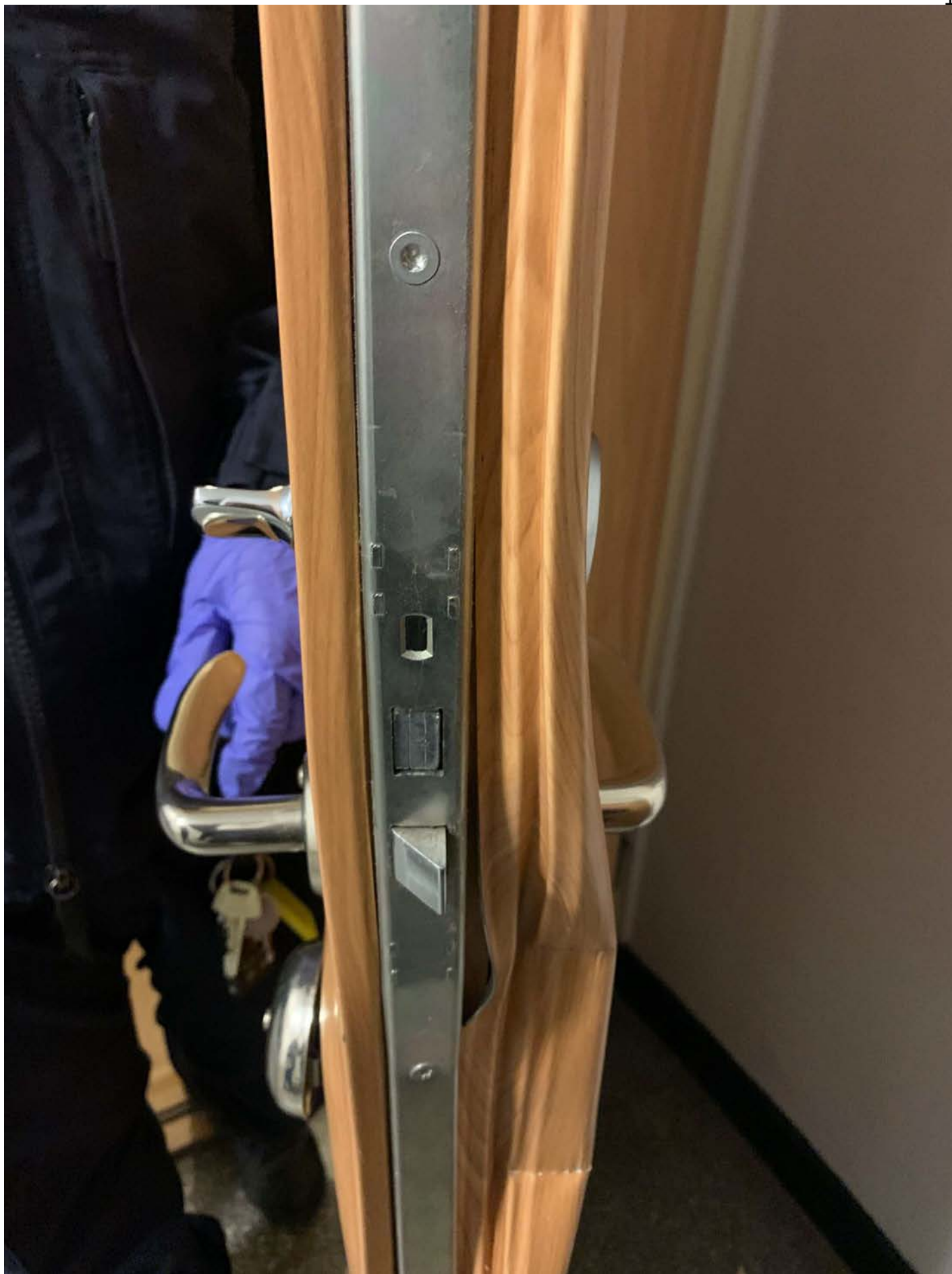
53. Närbild på låsbeslag på dörren in till lägenheten.
