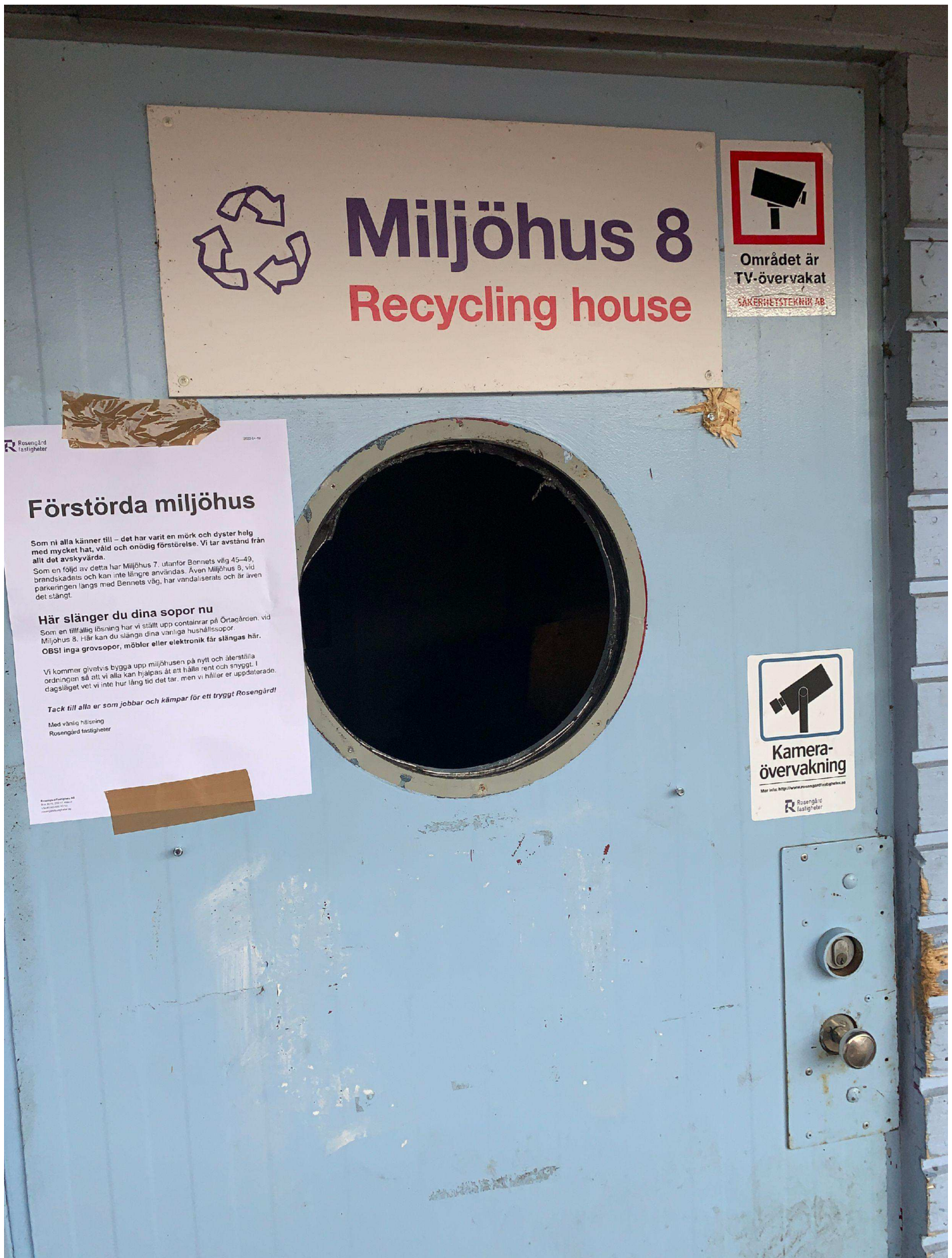
2. Bild på miljöhuset, tagen 220420.
