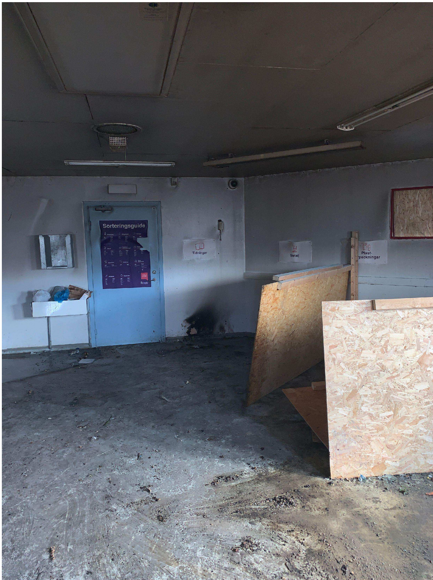
7. Bild tagen inne i miljöhuset, 220420.
