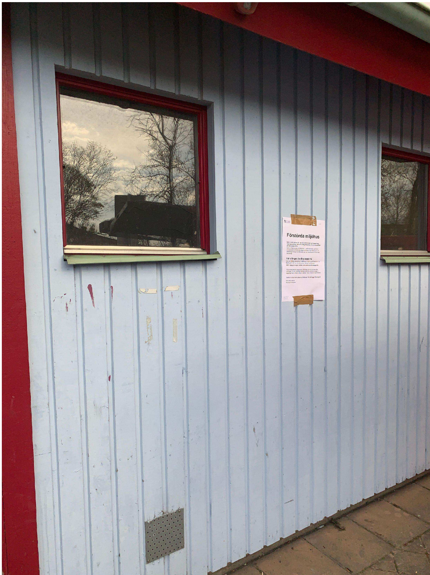
3. Bild på miljöhuset, tagen 220420.
