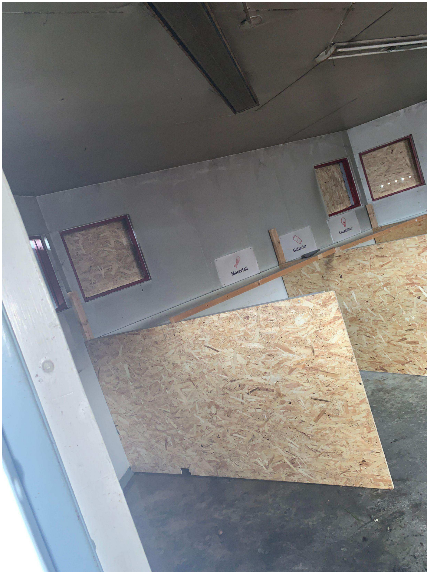
9. Bild tagen inne i miljöhuset, 220420.
