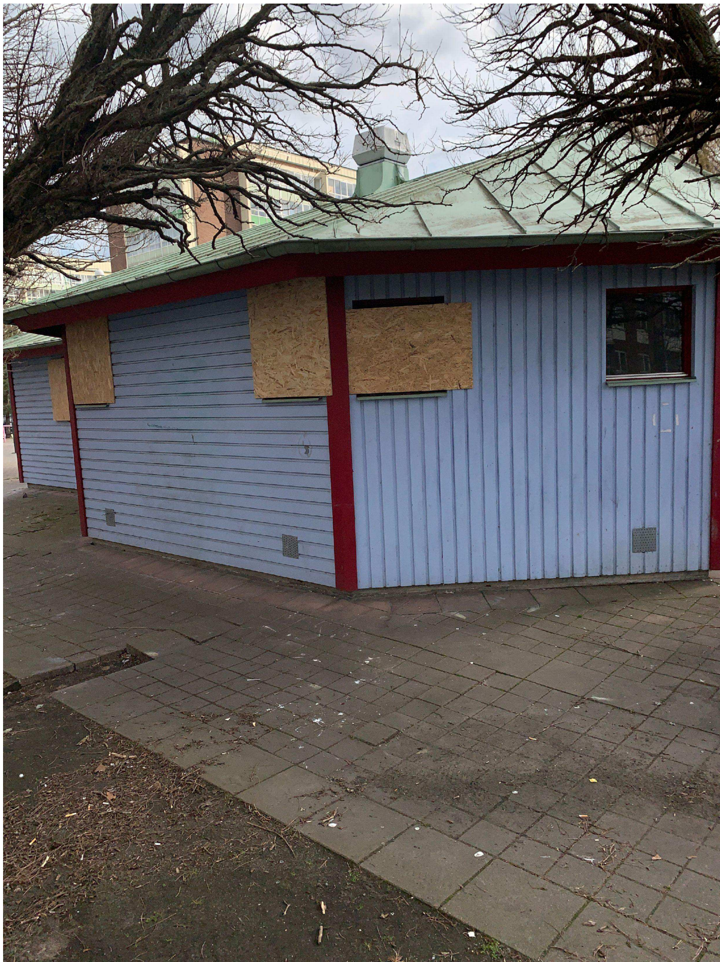
1. Bild på miljöhuset, tagen 220420.
