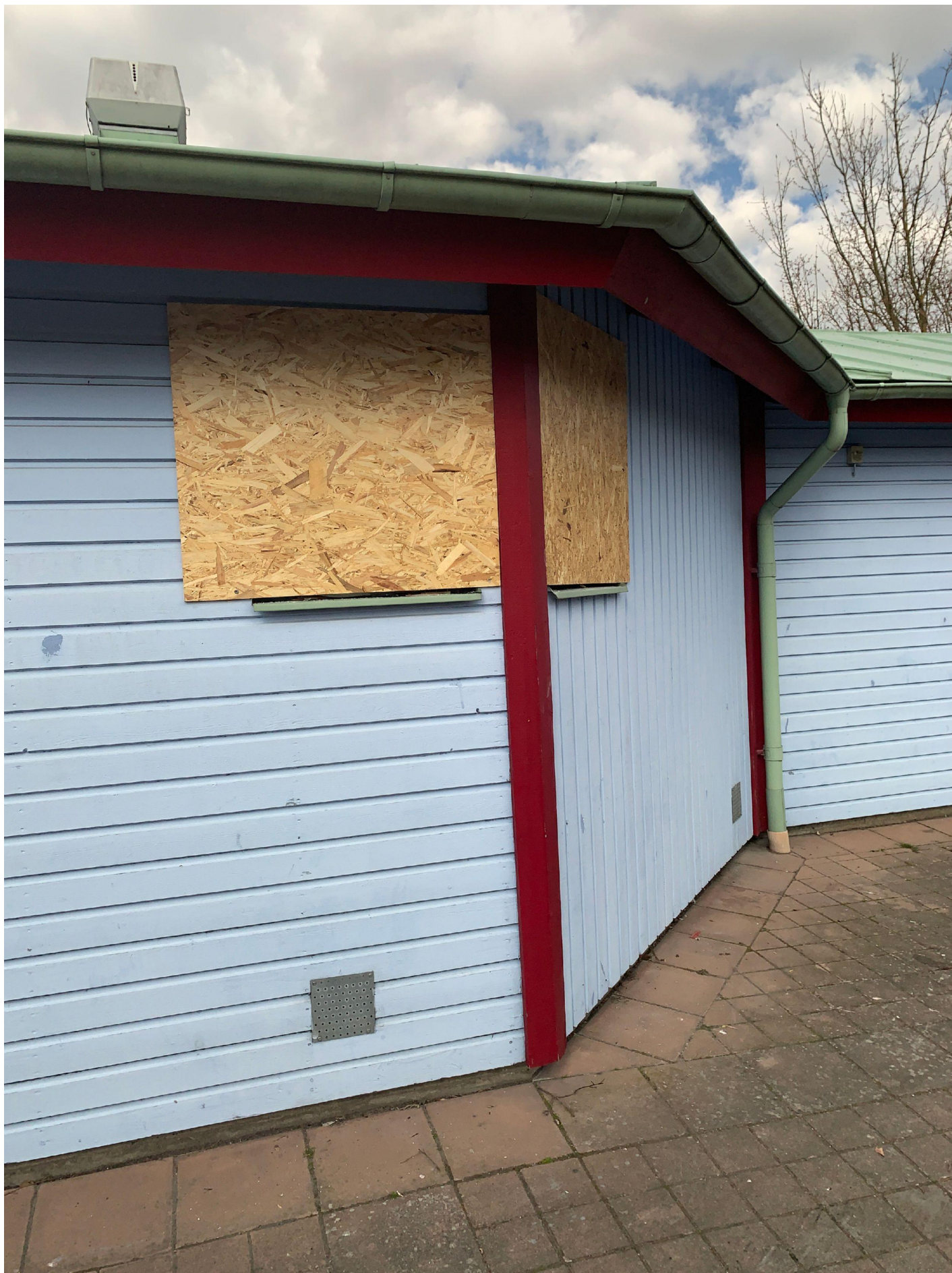
4. Bild på miljöhuset, tagen 220420.
