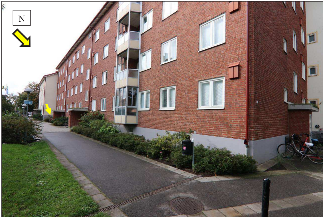
Figur 3. Augustenborgsgatan 18 B fotograferat från norra sidan av fastigheten. Pil markerar entrén till trapphuset.
